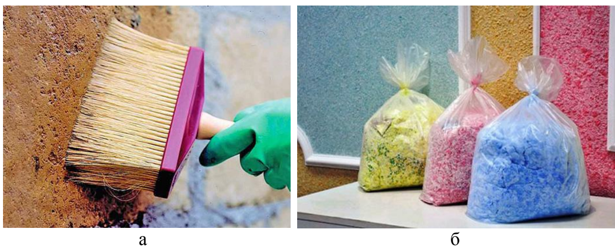
3-расм. Суюқ гулқоғозни сувашдан олдин грунтоткалаш сурати (а) ва қуруқ аралашма (б).
