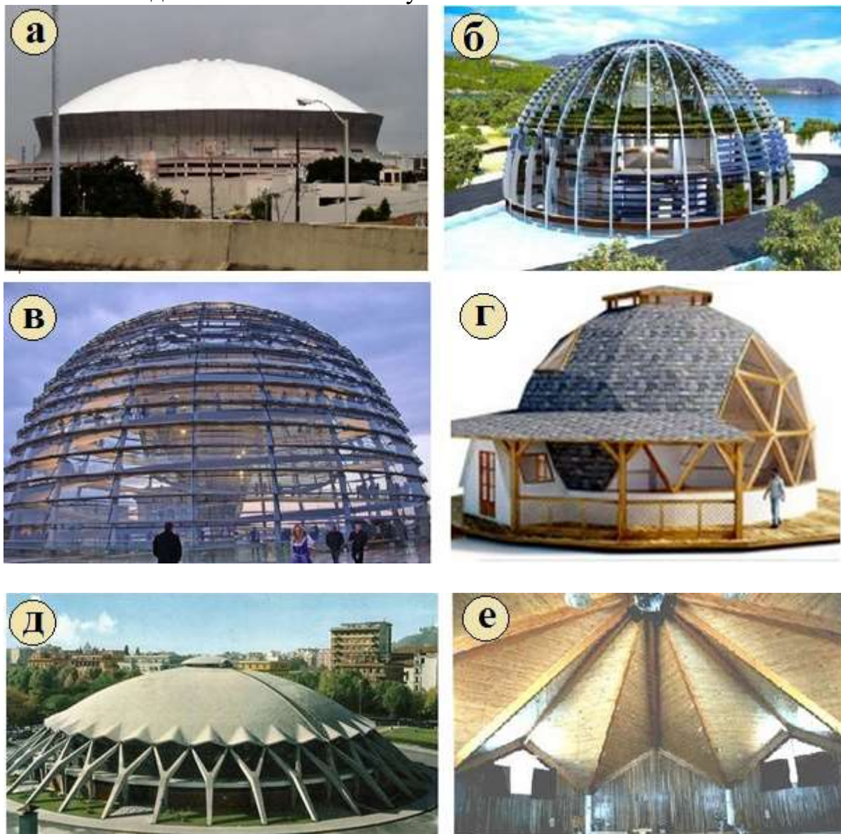
Рис. 2.40. Типы конструкций куполов: а – гладкий; б – ребристый; в – ребристо-кольцевой; г – кристаллический; д – звездчатый; е - складчатый
