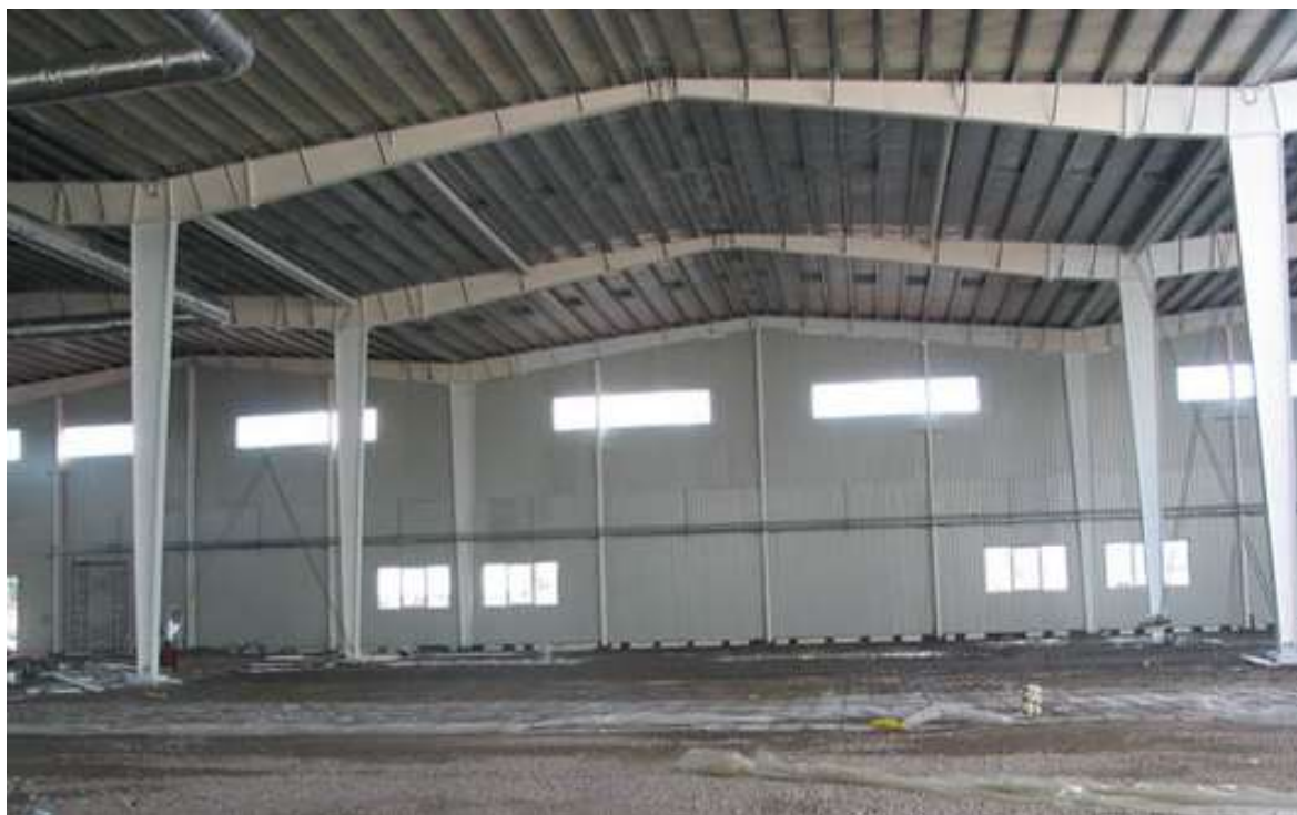
Рис. 2.22. Трёхшарнирная рама сплошного сечения с консолями
