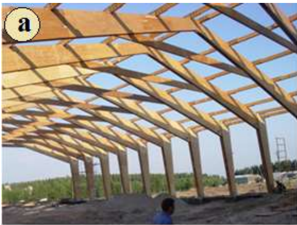
Рис. 2.28. Деревянные рамы зданий: а – с монтажным сопряжением ригеля и стойки; б – из гнутой древесины
