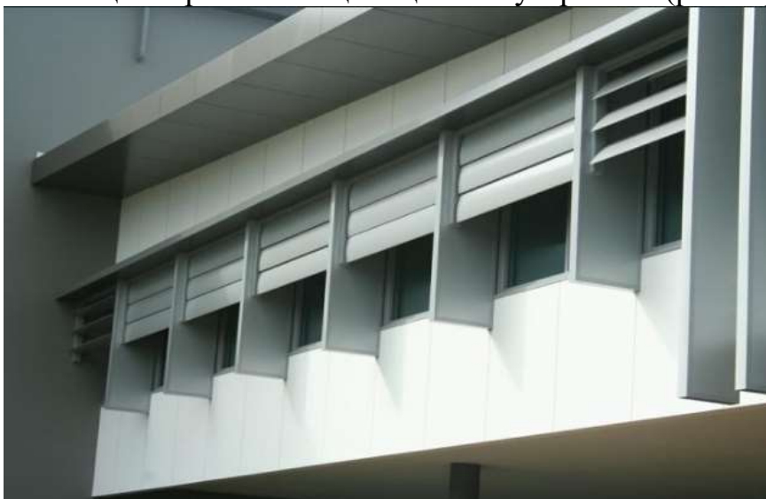
Рис. Пр2.6. Стационарные солнцезащитные устройства комбинированного типа
