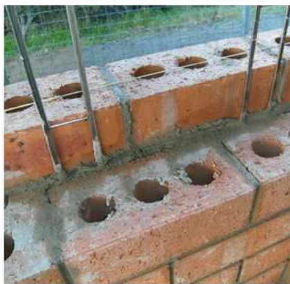
Рис. Пр1.32. Вертикальное армирование кладки
