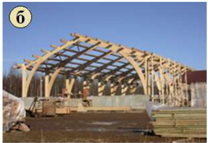
Рис. 2.28. Деревянные рамы зданий: а – с монтажным сопряжением ригеля и стойки; б – из гнутой древесины
