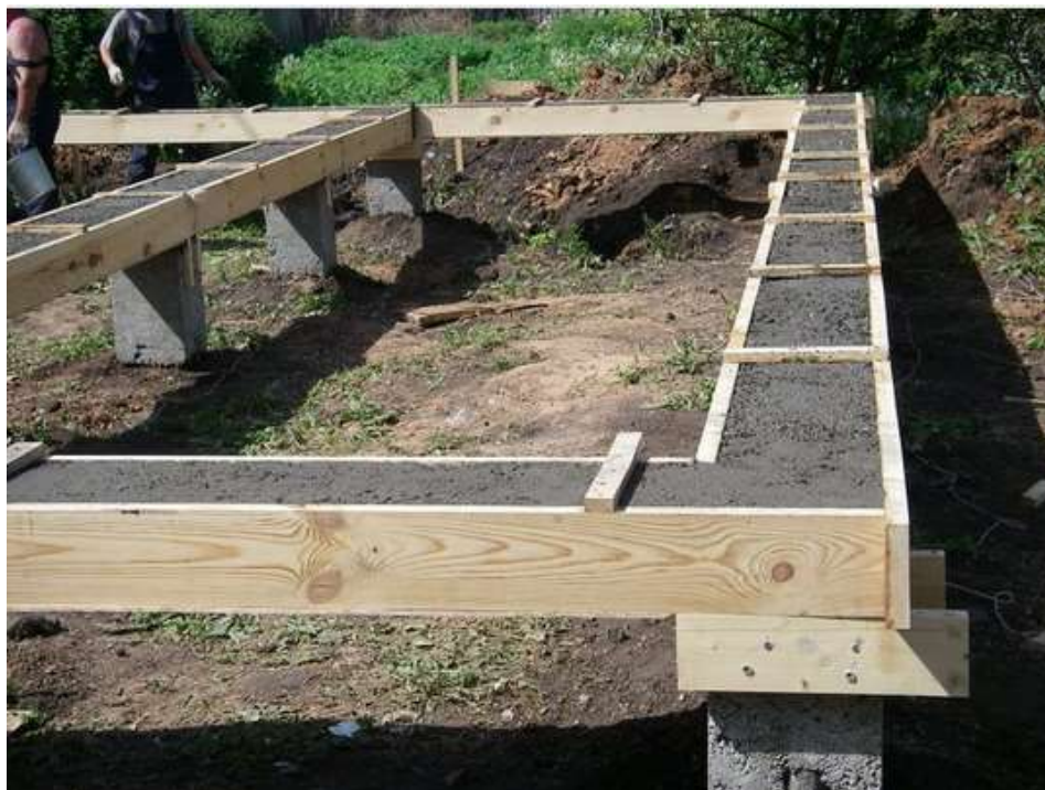
Рис. Пр1.18. Устройство свайного фундамента
