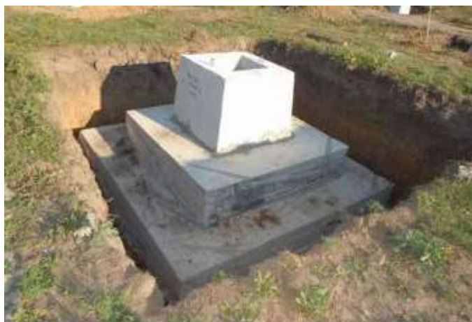
Рис. Пр1.11. Сборный подколонник и монолитные фундаментные плиты
