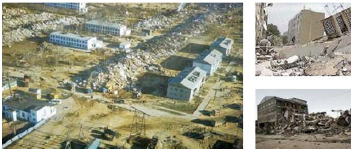
Рис. 3.2. Разрушительные землетрясения на Сахалине и Камчатке (Россия)
