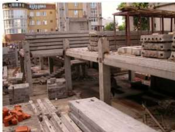
Рис. Пр1.33. Возведение здания из каркаса серии 1.020.1/87
