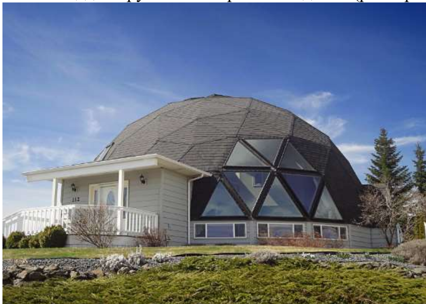
Рис.Пр2.5. Сокращение площади наружных ограждений путем применения формы объема здания в виде полусферы
