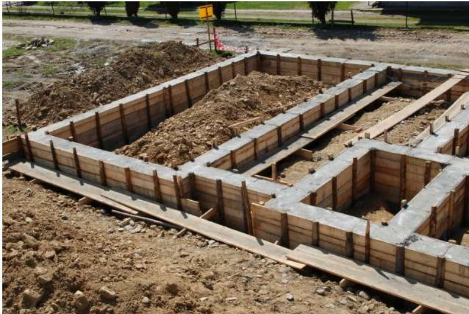
Рис. Пр1.4. Устройство железобетонного ленточного фундамента
