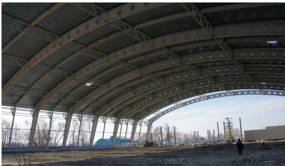
Рис. 2.23. Металлические рамы сплошного сечения пролетом 80 м
