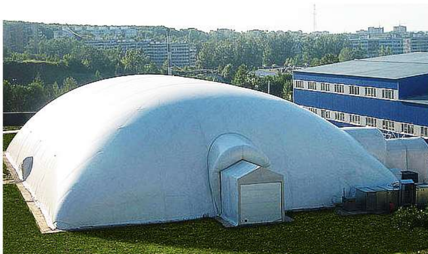
Рис. 2.49. Воздухоопорная однослойная оболочка
