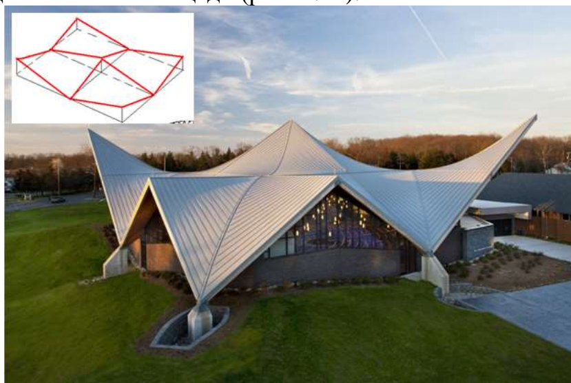
Рис. 2.42. Шатровый блок из четырёх гипаров
