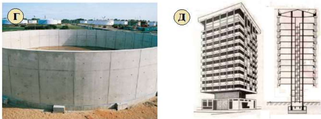
Рис. 1.6. Основные конструктивные системы гражданских зданий: а – бескаркасная (стенная); б – каркасная; в – объёмно-блочная; г – оболочковая; д – ствольная
