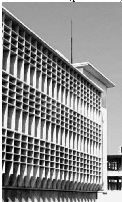
Рис. П2.34. Комбинированные солнцезащитные устройства
