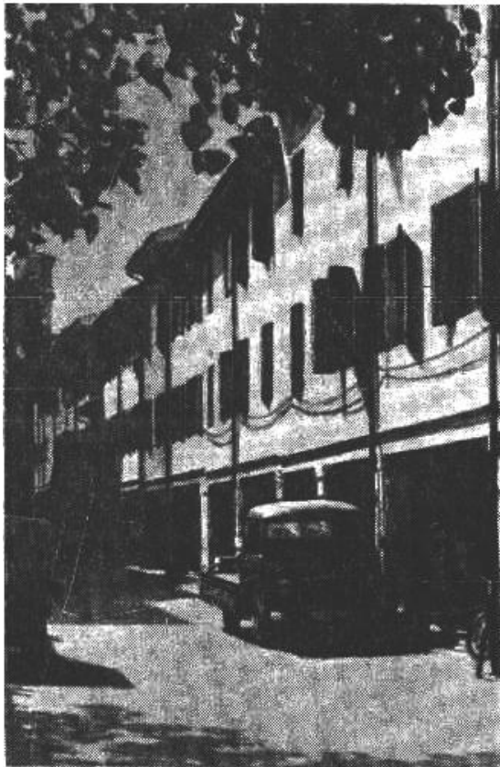
Пример консервирующей реставрации в районе Св. Леонардо (участок № 9). Ряд новых зданий построен по старой красной линии и заполняет разрыв по виа Св. Леонардо
