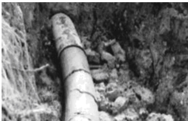
2.3–расм. Қувурдан грунт қатламини тортиб олиш.
