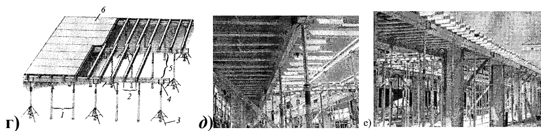
4.21–расм. ФАРЕЗИН фирмасининг қолипи, икки каркасли ораёпмалар:
