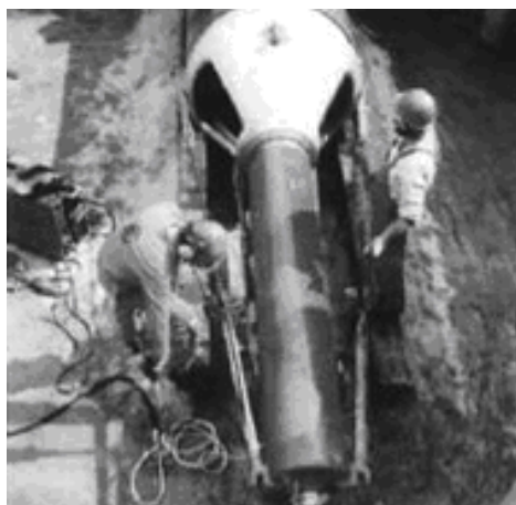
2.2–расм. Пневматик тешиш қурилмаси ёрдамида қувурни қоқиш (а); сиқилган ҳаво ёрдамида қувурларни тозалаш қурилмаси (б).
