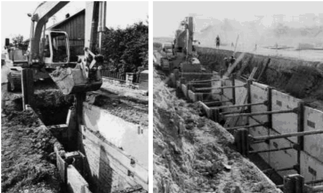
2.7–расм. Инвентар қолипдан фойдаланиш асосида, экскаваторнинг тескари кураги ёрдамида чуқур траншея (11 метргача) қазилни амалга ошириш.
