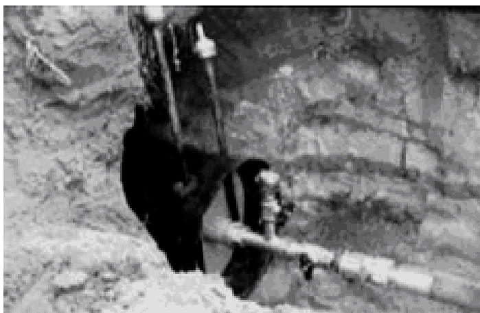
2.2–расм. Пневматик тешиш қурилмаси ёрдамида қувурни қоқиш (а); сиқилган ҳаво ёрдамида қувурларни тозалаш қурилмаси (б).
