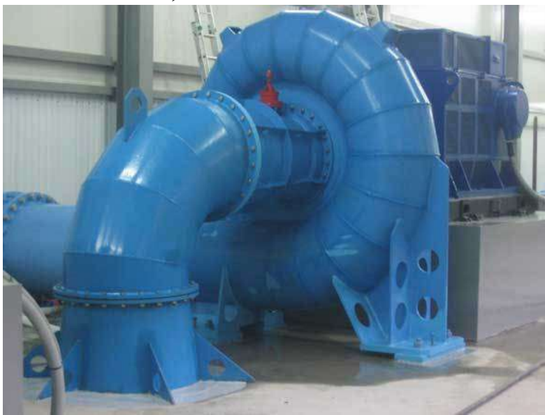
4.4-расм. Тўғри ўқли конуссимон ( a ) ва тирсаксимон ( б ) сўриб кетиш қувурли парракли гидроагрегатлар.
