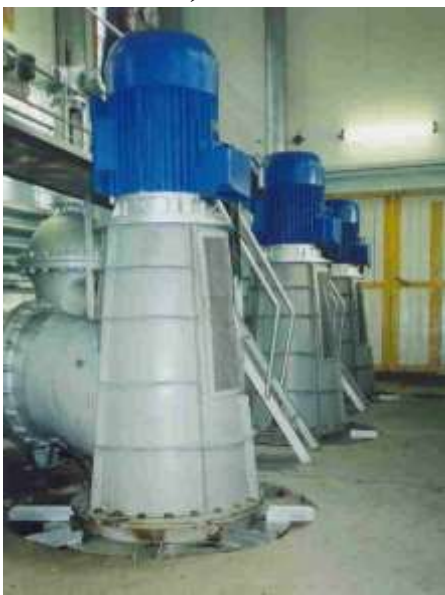
4.4-расм. Тўғри ўқли конуссимон ( a ) ва тирсаксимон ( б ) сўриб кетиш қувурли парракли гидроагрегатлар.
