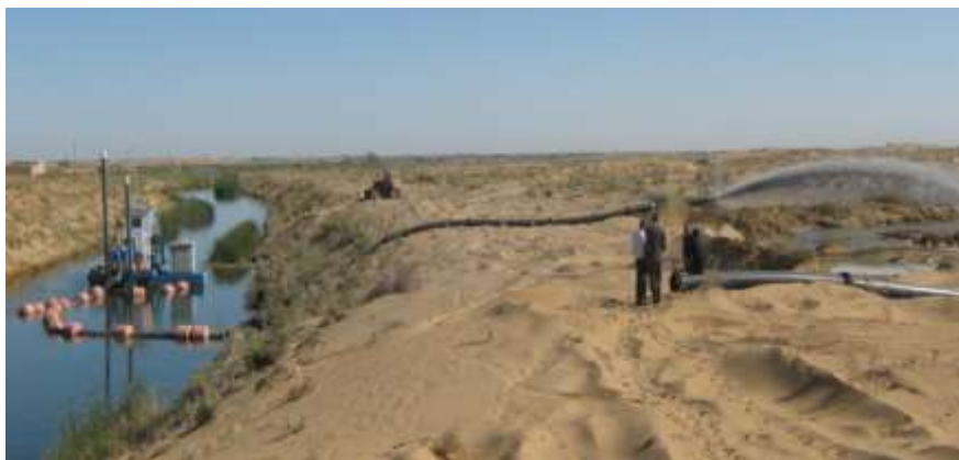
3.6-расм. №3 технологик схема бўйича коллектор ўзанини земснаряд билан чуқурлаштириш кўриниши.
