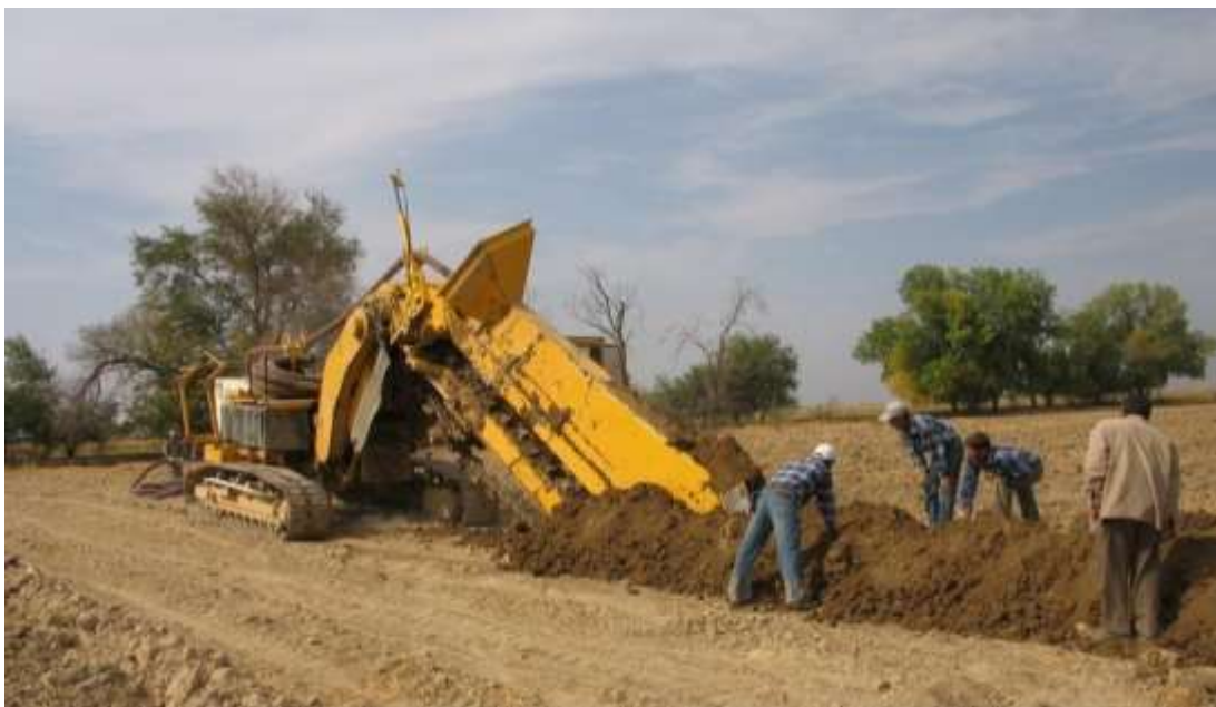
2.3 расм Ёпиқ горизонтал дренаж қуриш жараёни.
