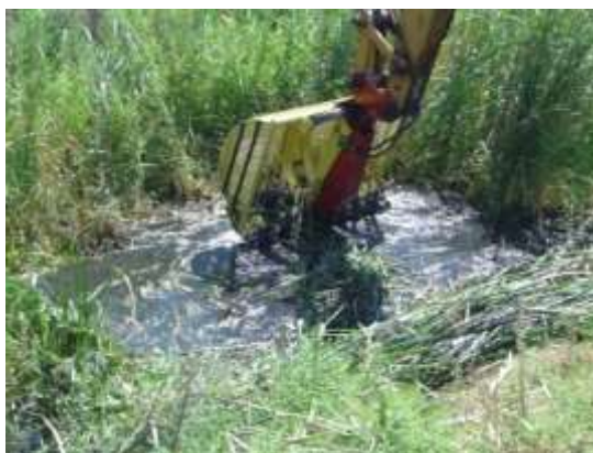
3.12-расм. Дағал пояли ўсимликларни бир чўмичли гидравлик экскаваторлар ва уларга илиниб ишлайдиган ковш ўргич билан сув остидан ўриб тозалаш.
