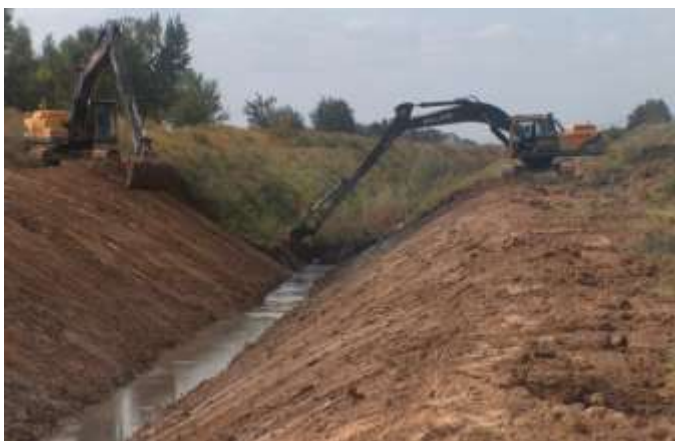
3.4- расм. Коллекторни №2 технологик схема бўйича, тескари чўмичли гидравлик экскаватор билан 2 марта ўтганда таъмирлаш-тиклаш иши кўрсатилган.
