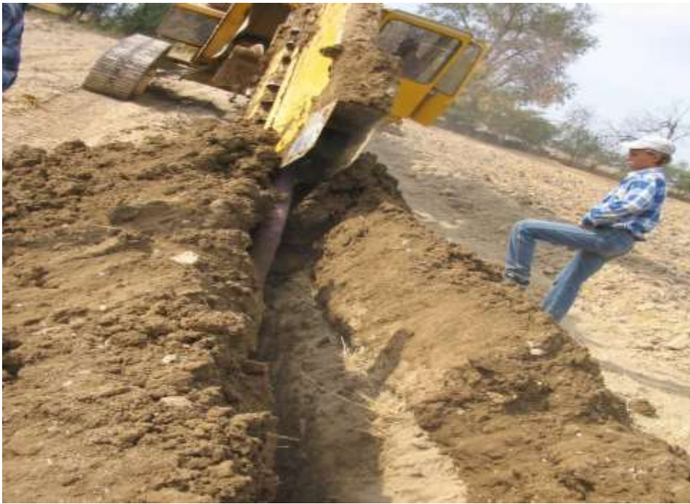
2.4 расм. Ёпиқ горизонтал дренаж қуриш машинаси ётқизиш бункери
