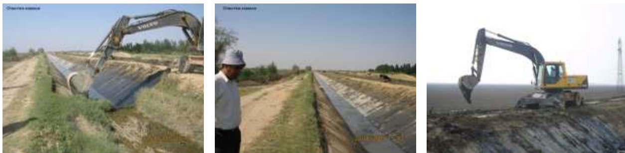
8.6- расм. Қопламали каналларни махсус чўмичли экскаватор билан тозалаш технологияси
