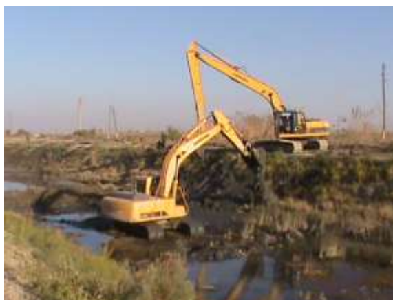
3.8-расм. №4 технологик схема бўйича коллектор ўзанини тозалаш кўриниши
