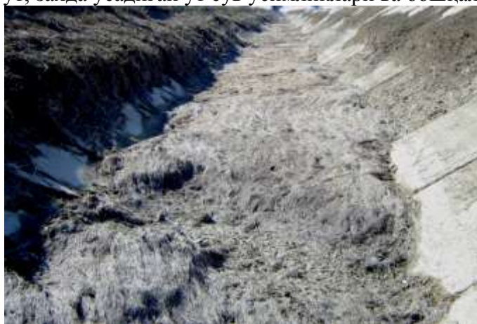
3.10-расм. Қопламали каналларда ўсган, барглари сув ичида бўладиган сув ўсимликлари кўриниши
