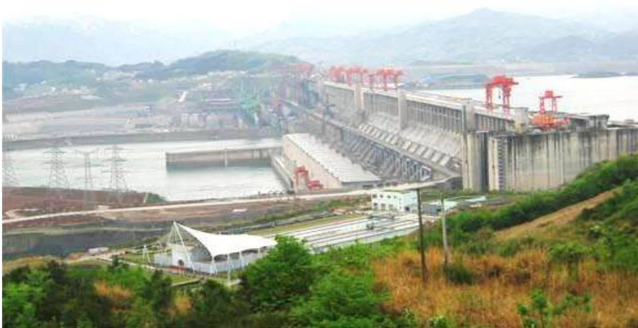
1.2-расм. Дунёдаги энг катта Уч дара гидроэлектростанцияси
