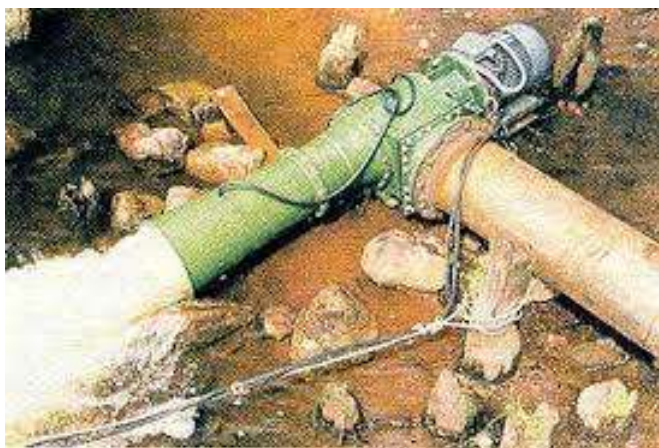
6.2-расм. МикроГЭС 10 Прнинг металл қувурлар (а) ва брезентли қувурлар (б) билан улаб эксплуатация қилиш ҳолатлари.
