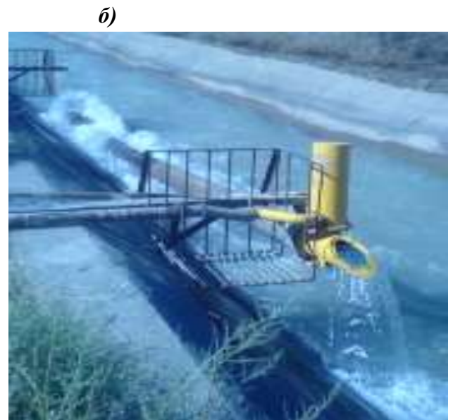
6.4-расм. Гидравлик таранни ўрнатиш схемаси (а) ва нишаблиги катта бўлган каналга ўрнатилган гидравлик таран (б): а - 1 ва 5 - сув узатувчи ва босим қувури; 2 ва 3 - сув чиқарувчи ва босим клапанлари; 4 - ҳаво қалпоғи; 6-босимли идиш; 7-сув манбаси
