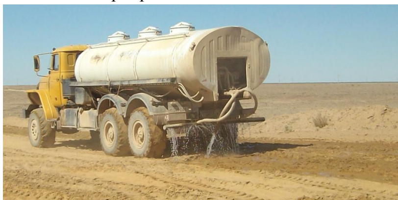
14- расм. Грунт намлигини оптимал қийматга етказиш учун сув сепиш жараёни
