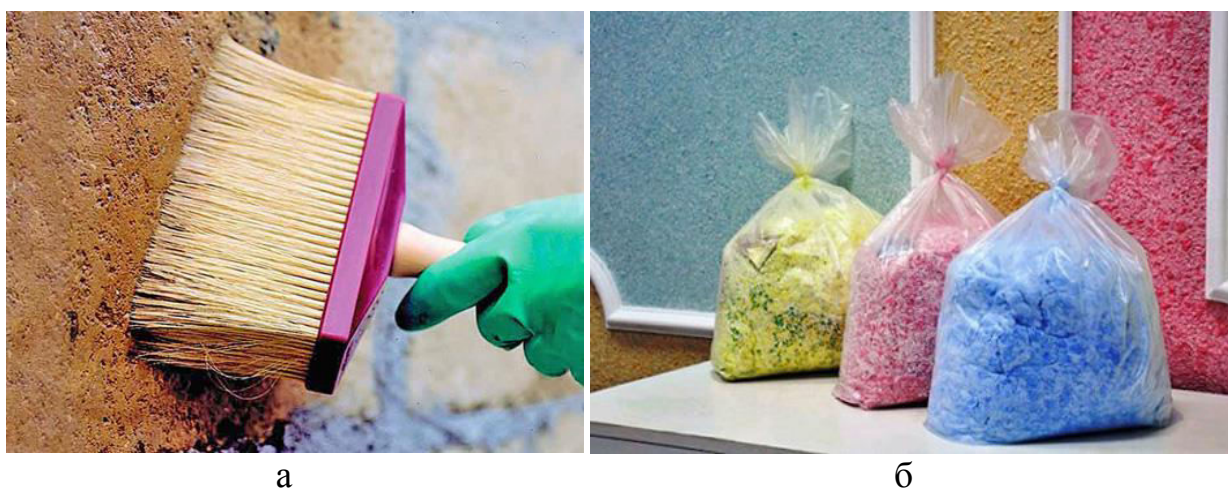
3-расм. Суюқ гулқоғозни сувашдан олдин грунтоткалаш сурати (а) ва куруқ аралашма (б).
