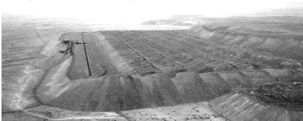
Рис. 1.24.2. Пример формирования нижнего яруса отвала устойчивой высоты
