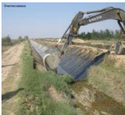
139- расм. Қопламали каналларни махсус чўмичли экскаватор билан тозалаш технологияси
