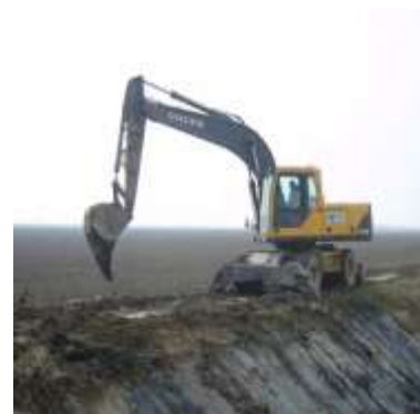
139- расм. Қопламали каналларни махсус чўмичли экскаватор билан тозалаш технологияси
