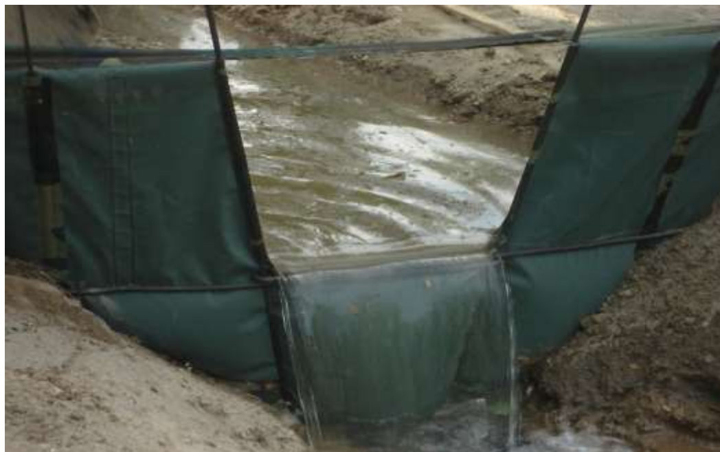
48-расм. Кўчма сув ўлчагични лабораторияда текшириш: а) юқори бьефдан кўриниши; б) пастки бьефдан кўриниши
