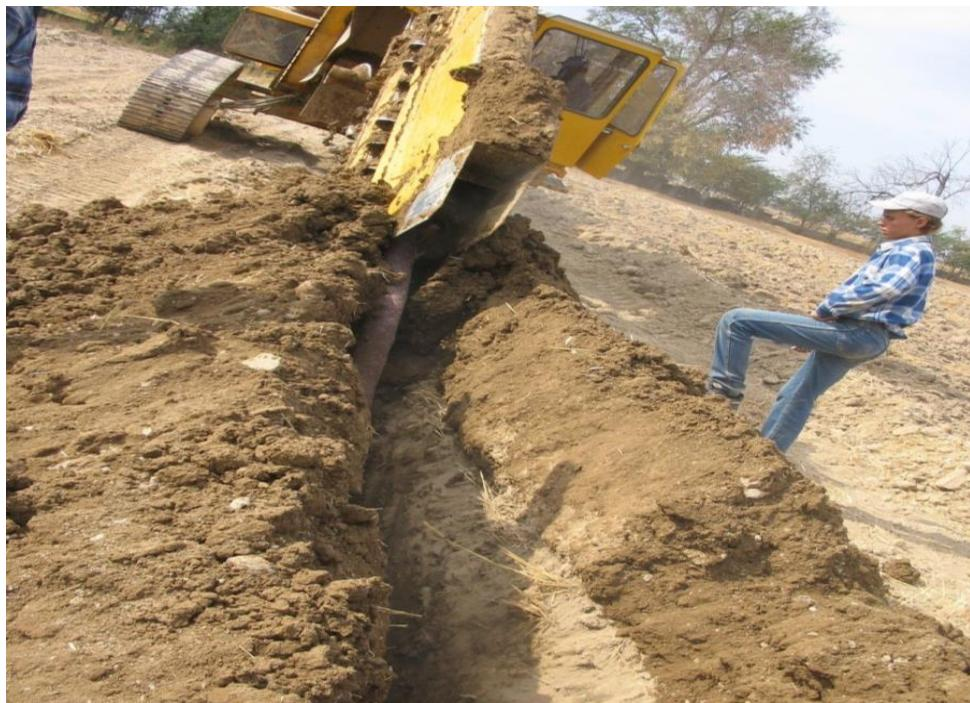
2.4 расм. Ёпик горизонтал дренаж қуриш машинаси ётқизиш бункери
