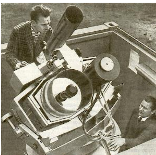
20-расм. “Интеркосмос” лазер узокни ўлчагичи
