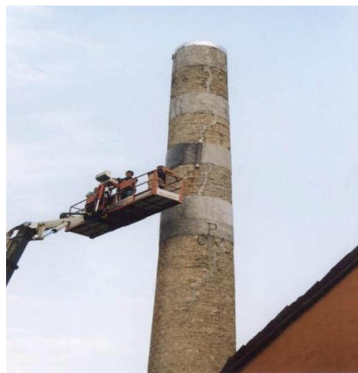
Вертикал ёриқдаги бузулган ғиштли труба
