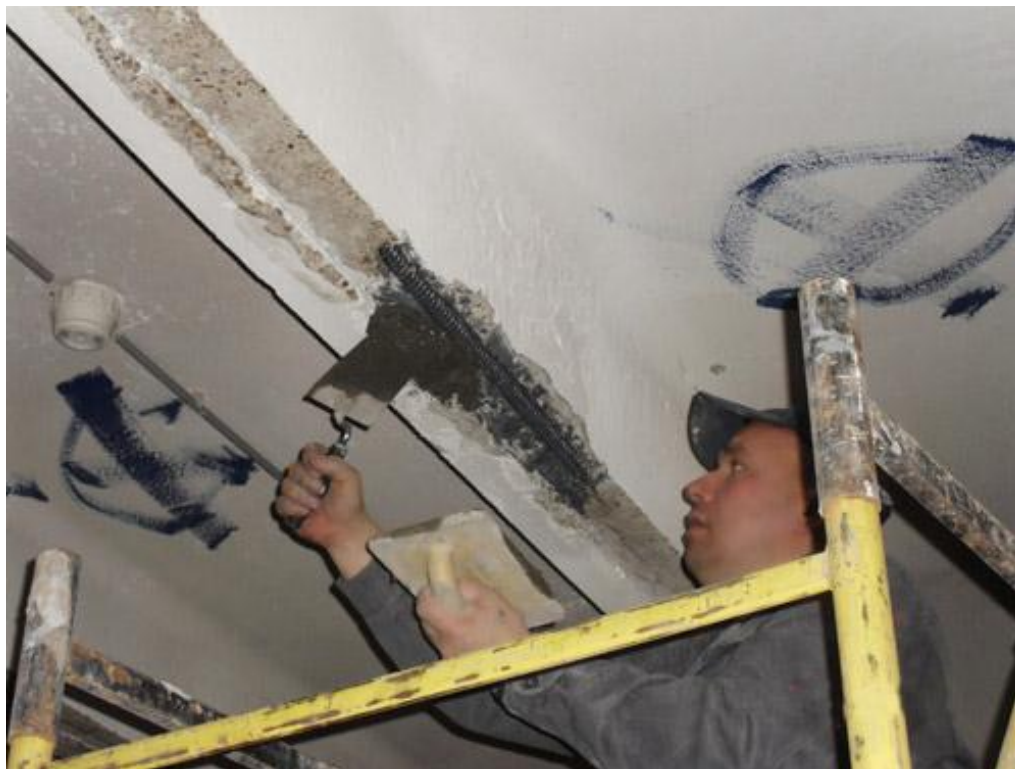
Бетоннинг химоя қатламини полимерцент таркиби билан тиклаш
