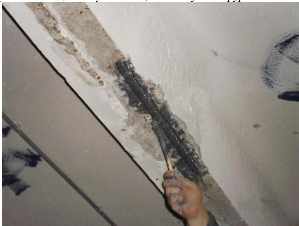
Арматурага антикоррозия таркибини киритиш
