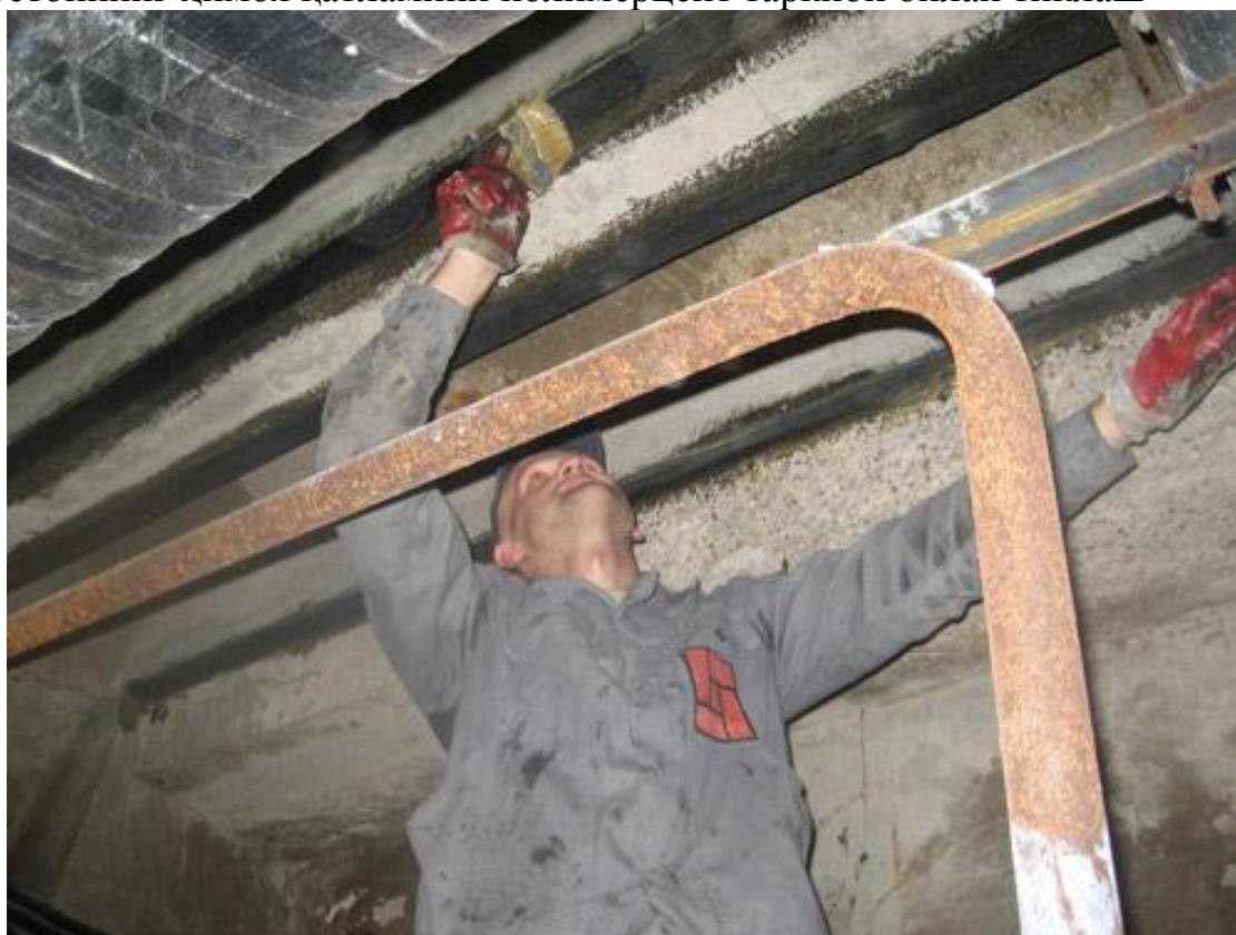
Бетоннинг химоя қатламини полимерцент таркиби билан тиклаш
