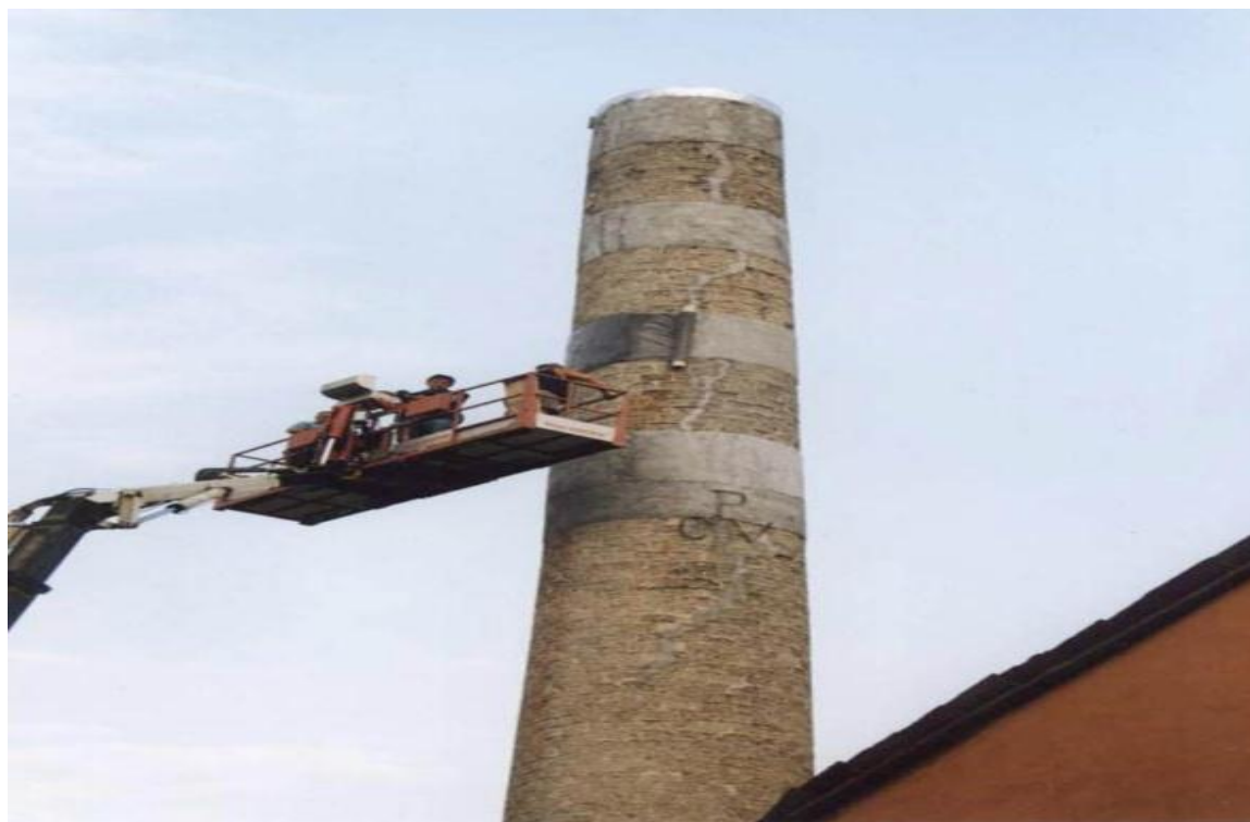
Вертикал ёриқда шикастланиши фойдаланадиган гишт трубани кучлантириши
