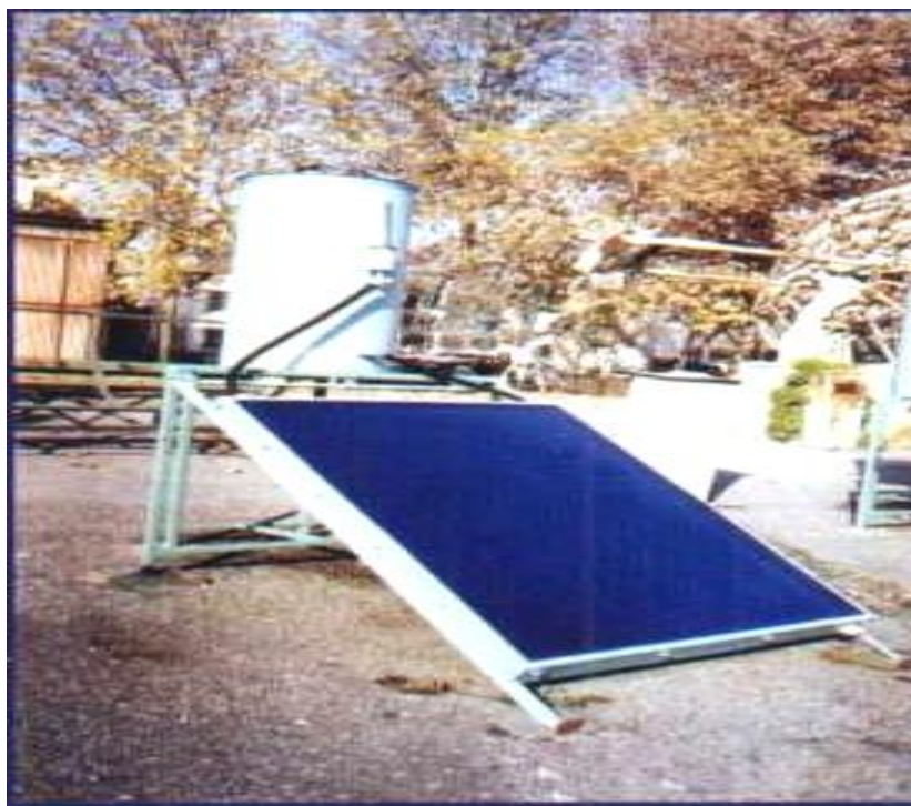
2.12- расм. Қуёш иситгичининг сатҳи 2 м 2 ва иссиқ сув жамловчи бакининг ҳажми 140 л бўлган 2 контурли сув иситгич қурилма
