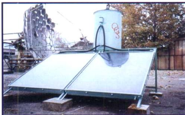
2.13-расм. Қуёш иситгичининг сатҳи 4 \text{ м}^2 ва иссиқ сув жамловчи бакининг ҳажми 300 л бўлган 2 контурли сув иситгич қурилма
