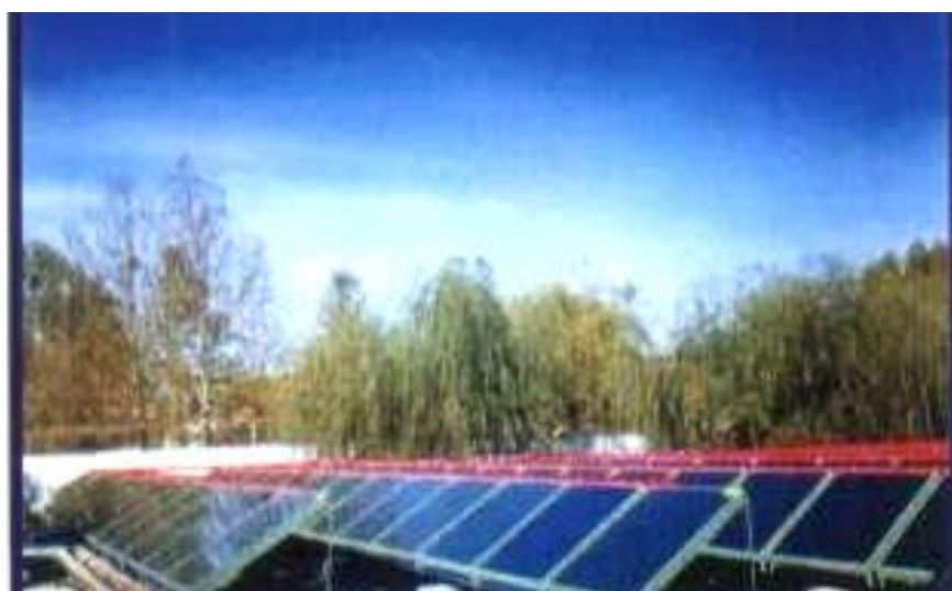
2.16-расм. Анъанавий ёқилғи ҳисобига ишловчи қозонхона ҳудудида жойлашган ва кираётган сувни даслабки иситиб берувчи қуёш сув иситгич қурилмаси
