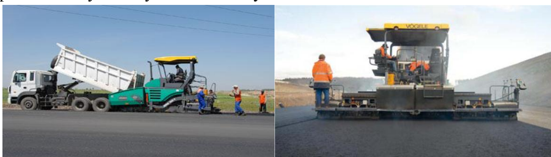
19-расм. Иссиқ асфальтобетон қоришмасини йўлга ётқизиш технологик жараёнида лавҳалар.
