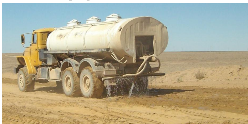
14- расм. Грунт намлигини оптимал қийматга етқозиш учун сув сепиш жараёни
