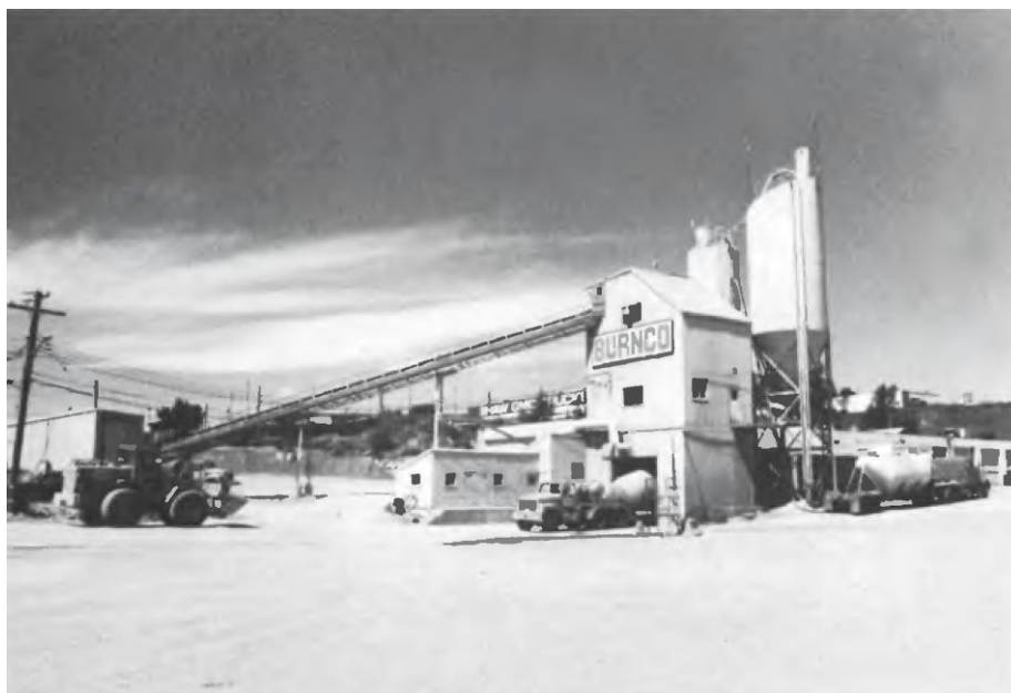
Расм 4-7. Бетон заводи 28
