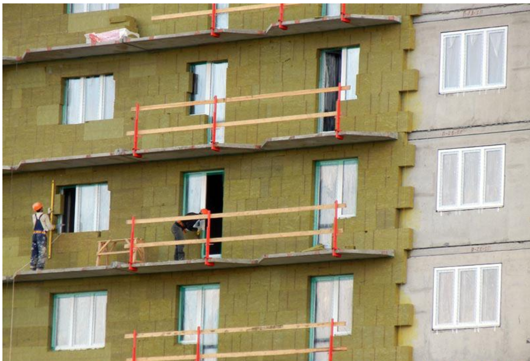
Расм 2.1 а. Мавжуд бўлган бинони минерал пахта плиталар билан иссиқлик изоляция.
