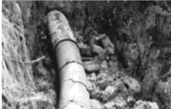
4.3–расм. Қувурдан грунт қатламини тортиб олиш.
