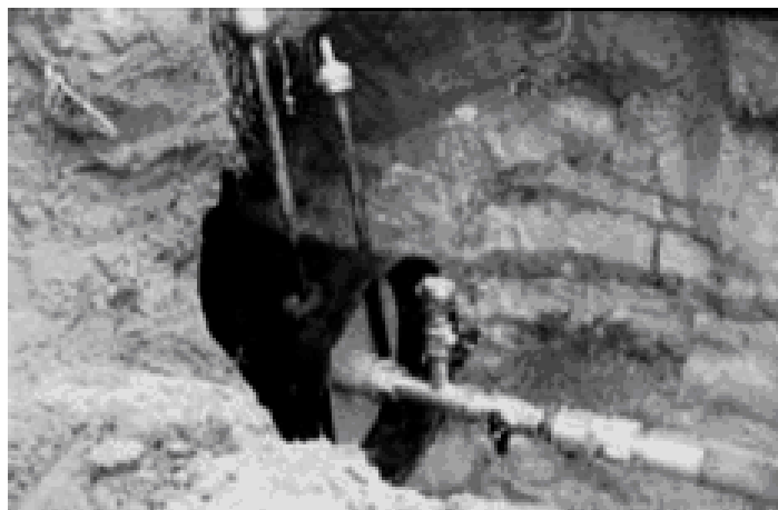
4.1., 4.2–расм. Пневматик тешиш қурилмаси ёрдамида қувурни қоқиш ( а ); сиқилган ҳаво ёрдамида қувурларни тозалаш қурилмаси ( б ).
