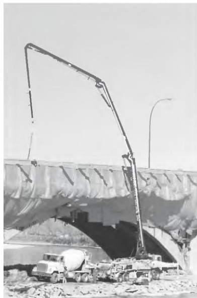
Расм 4-5. Гидравлик стрелалар мураккаб участкаларни бетонлаш имконини беради
