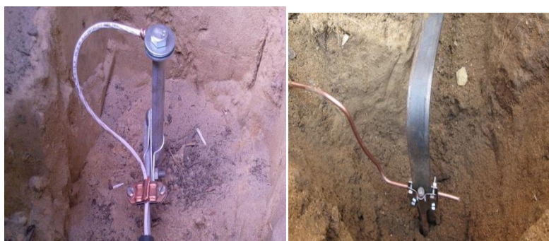
3.9 – расм. Вертикал электродларни траншеяга ўрнатиш қурилмаси
