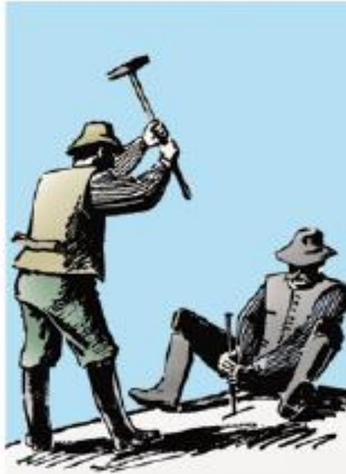
Рис-1. Бурение с кувалдой был установленный метод до развития перфоратора.
