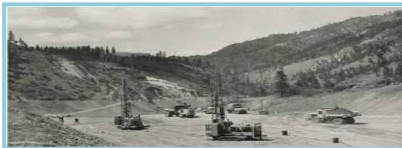
**Рис-5.** Первые пневматические станки компании Атлас-копко
