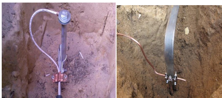
3.9 – расм. Вертикал электродларни траншеяга ўрнатиш қурилмаси
