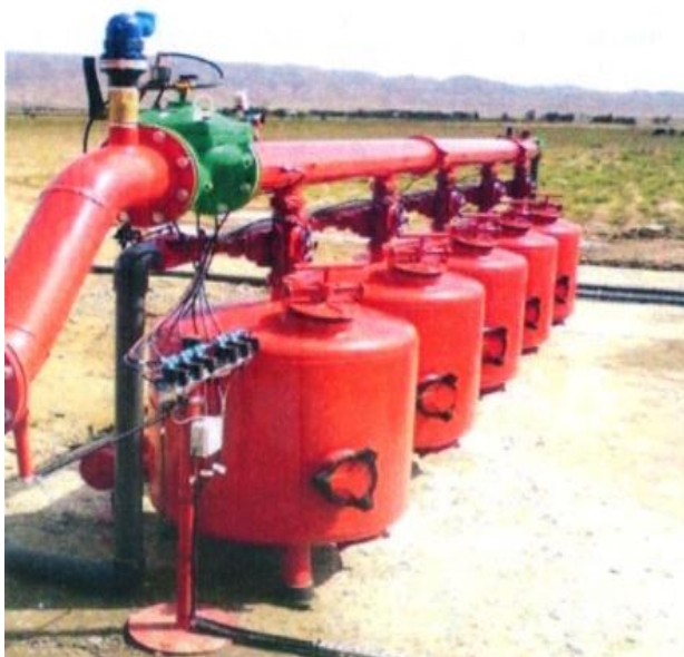
27-расм. Суғориш сувини тозаловчи қумли фильтрлаш қурилмаси.
