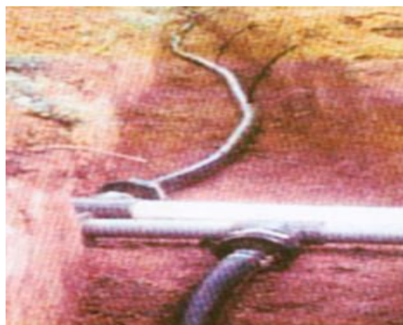
32-расм. Магистрал қувурга таксимлаш қувурини улаш.
