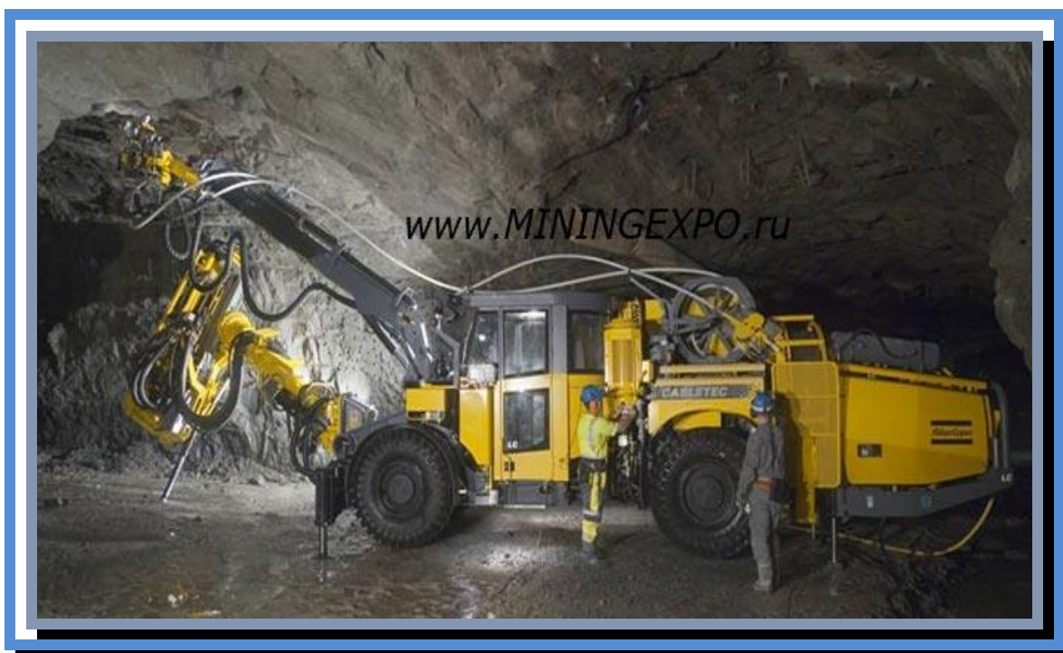
Возведение тросового крепления установкой «Кабелтек» (рудник «Брансвик» Канада)
