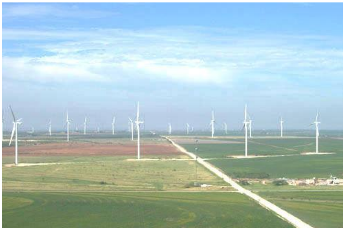
1.3 -расм. Энг катта қувватли шамол электростанцияси. Дунёдаги энг катта, сув сатҳнинг кўтарилиб -тушиш принципи асосида ишлайдиган гидроэлектростанция.
