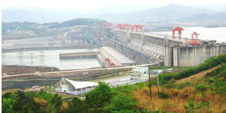
1.2-расм. Дунёдаги энг катта Уч дара гидроэлектростанцияси
