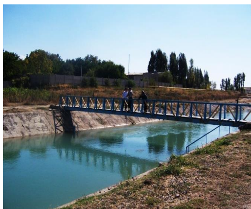
1.2-расм. Ўзгармас ўзан типидagi гидропост.
