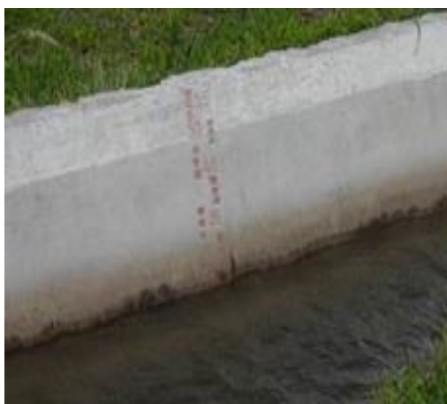
1.10-расм.Стандарт параболик нов.
