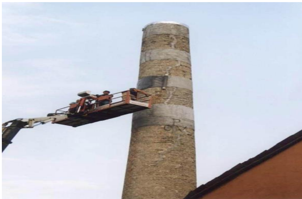
Вертикал ёриқда шикастланиши фойдаланадиган гишт трубани кучлантириши
