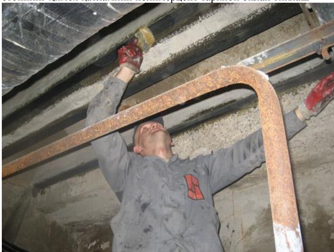
Бетоннинг химоя қатламини полимерцент таркиби билан тиклаш
