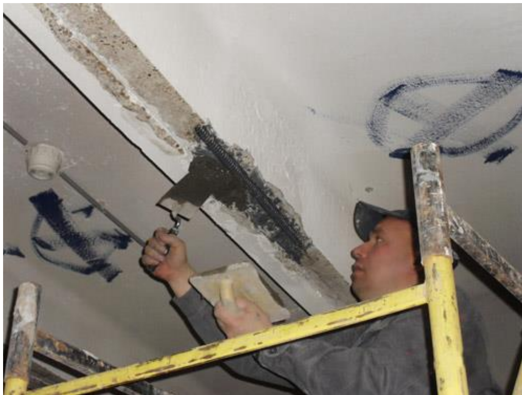
Бетоннинг химоя қатламини полимерцент таркиби билан тиклаш
