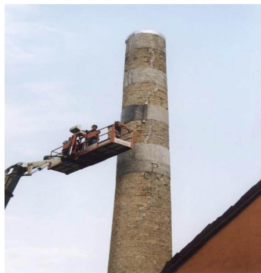
Вертикал ёриқдаги бузулган ғиштли труба
