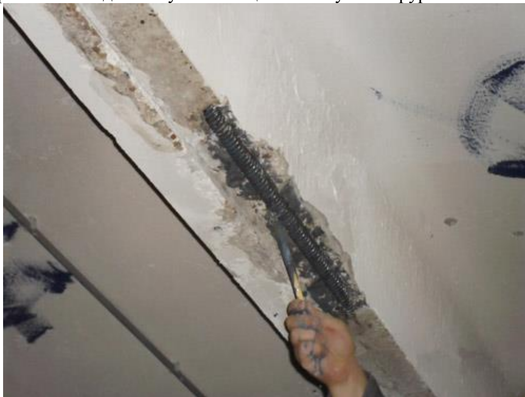
Арматурага антикоррозия таркибини киритиш
