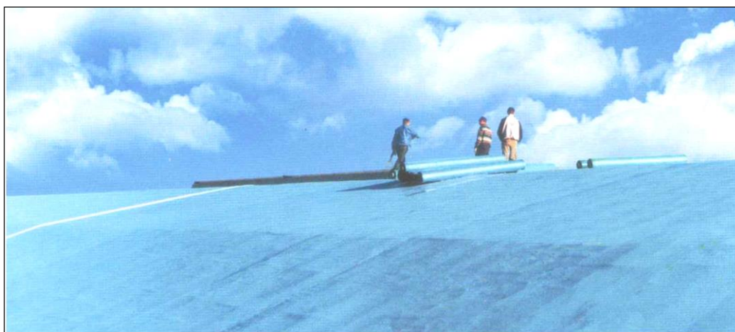
3.14-расм.. Тез барпо қилинувчи бионинг Алькопан мембранасидан қурилган том қопламаси
