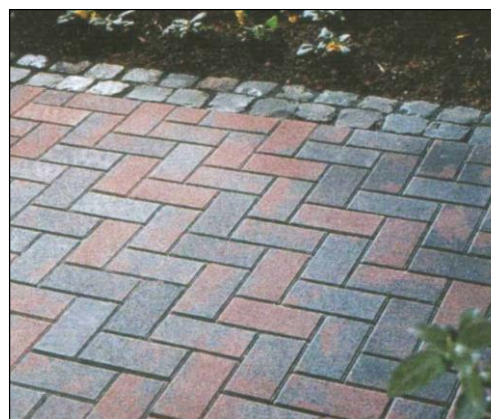
3.42-расм. Магистраль йўллар қопламаларини плиткалардан териш
