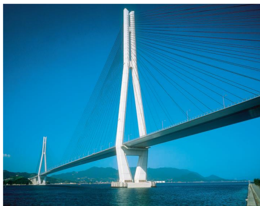
4.8-расм. Модификацияланган бетондан қурилган Токиодаги темирбетон кўприк
