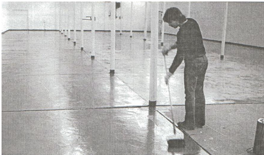
3.17-расм. Эпол эпоксидли-сланецли қуйма полларни карталар бўйича қуриш
