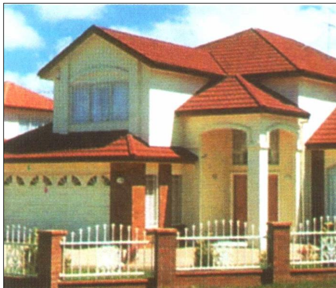
3.11-расм. Метробонд билан қопланган том
