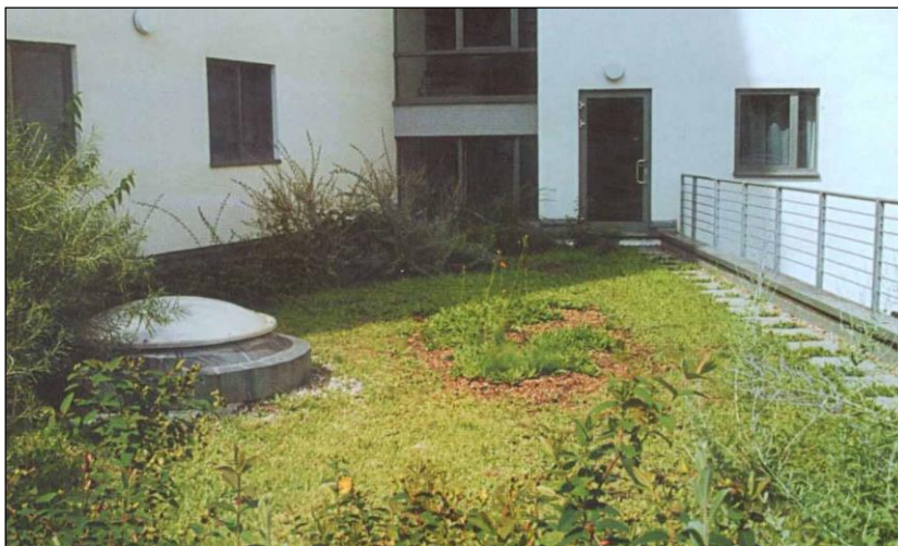
3.16-расм. Кўкаламзорлаштирилган том қопламаси
