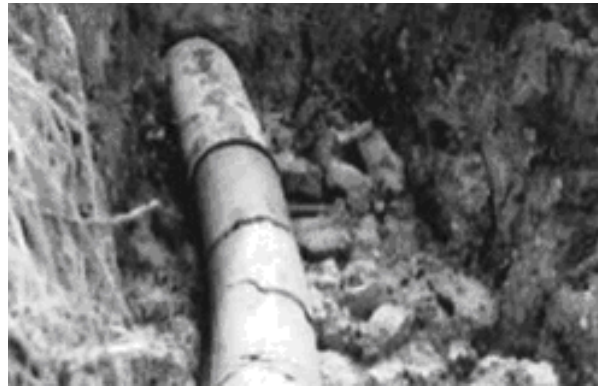
4.3–расм. Қувурдан грунт қатламини тортиб олиш.
