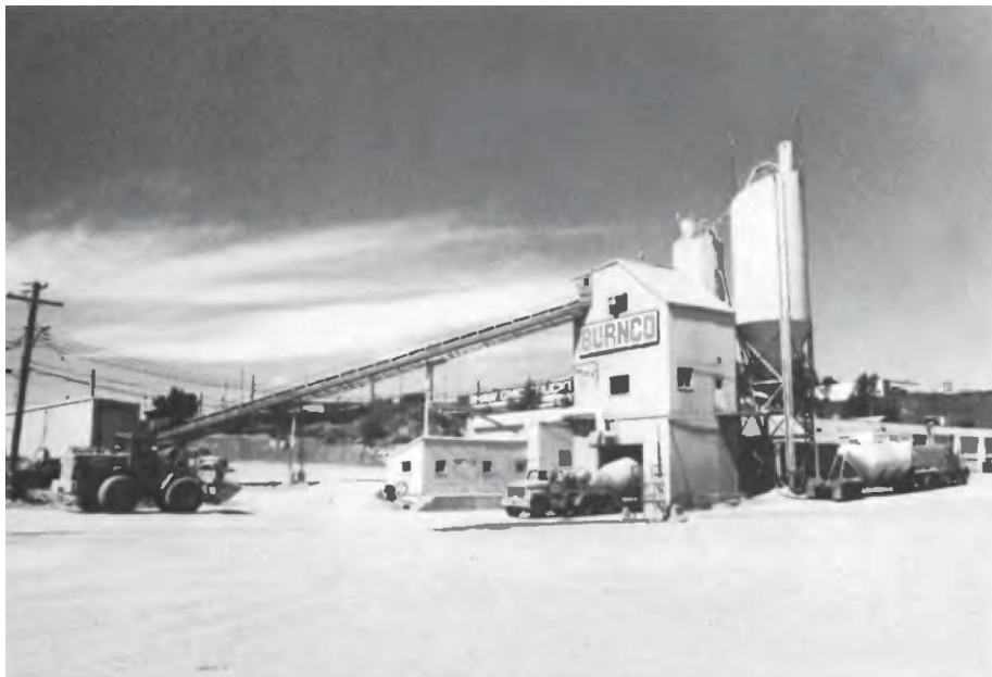
Расм 4-7. Бетон заводи 28
