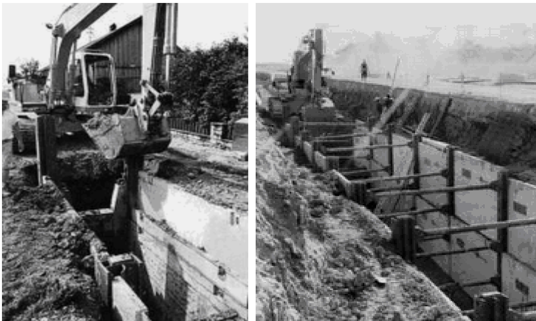
4.9–расм. Инвентар қолипдан фойдаланиб, экскаваторнинг тескари чўмичи ёрдамида чуқур траншея (11 метргача) қазил
