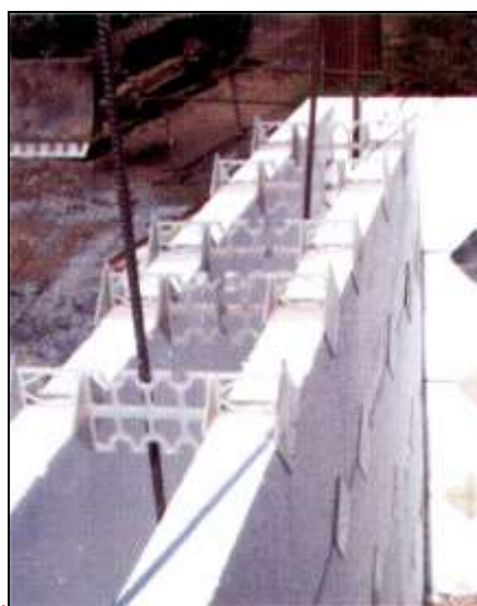
2.8-расм. Пенополистирол плитали олинмайдиган опалубка.
