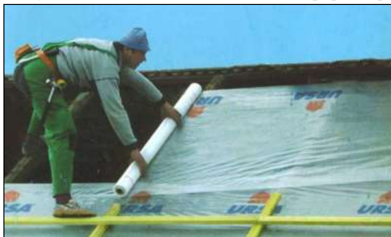
3.15-расм. "Урса-секо 500" асосидаги буғ-изоляцияси
