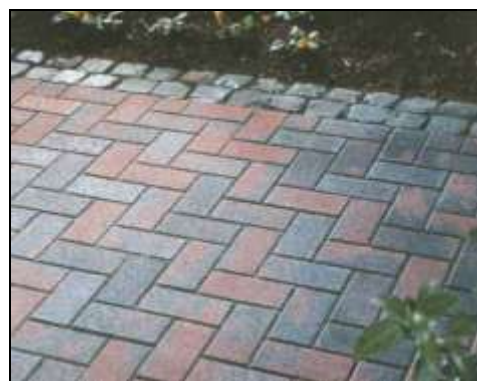
4.15-расм. Магистраль йўллар қопламаларини плиткалардан териш
