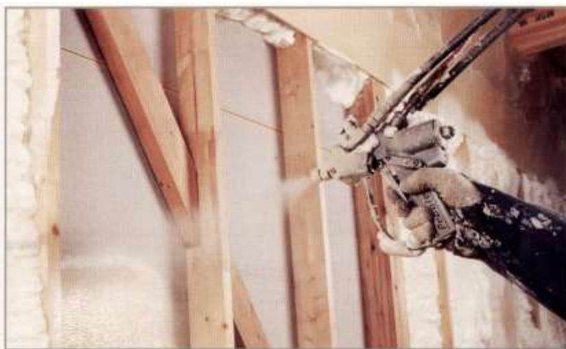
2.10-расм. Пуркаш усулини қўллаб илиқ пардеворни қуриш жараёни
