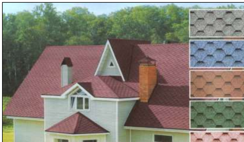
3.2.-расм. Катрилли «Катепал» плиткаларидан қурилган том.
