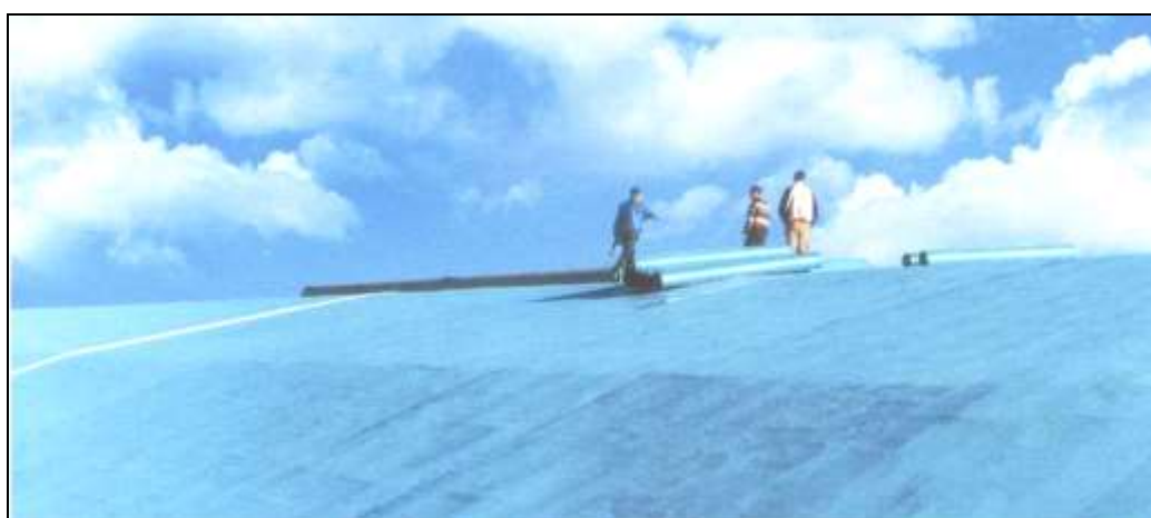
3.14-расм.. Тез барпо қилинувчи бинонинг Алькоплан мембранасидан қурилган том қопламаси.
