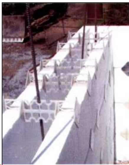
2.8-расм. Пенополистирол плитали олинмайдиган опалубка.
