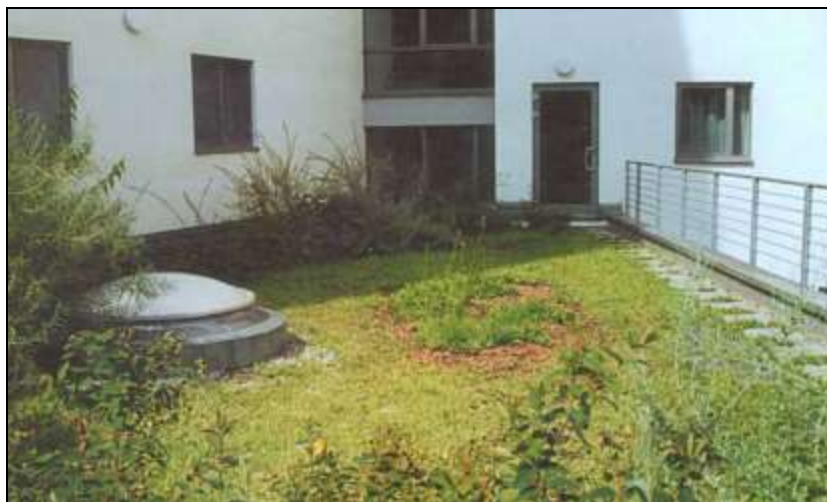
3.16-расм. Кўкаламзорлаштирилган том қопламаси.
