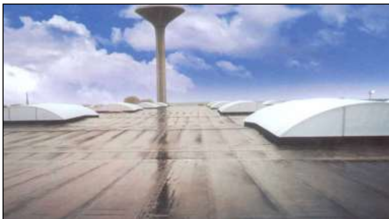
3.13-расм. Саноат биносининг Резитрикс материалдан қурилган том қопламаси
