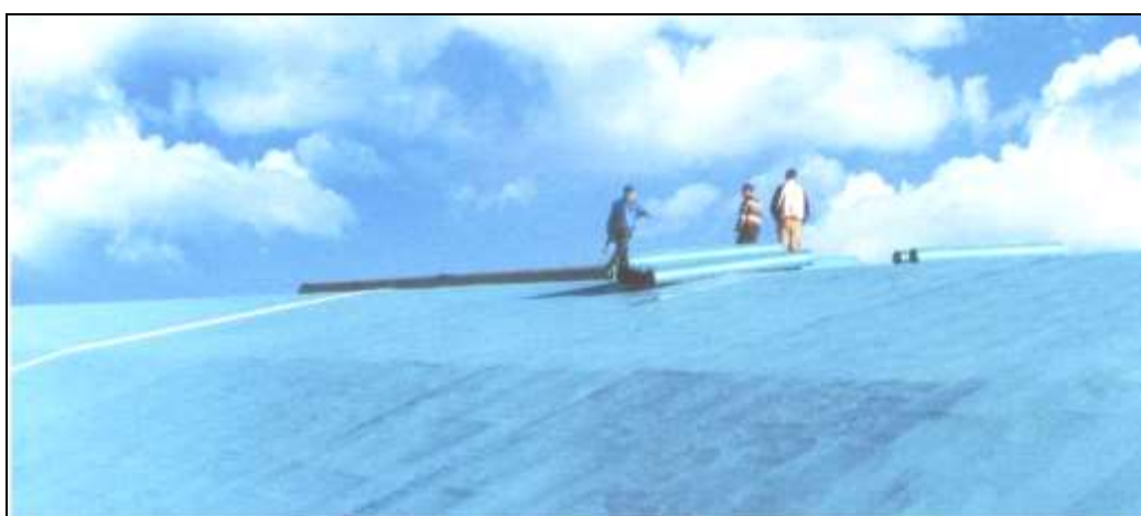
3.14-расм.. Тез барпо қилинувчи бинонинг Алькоплан мембрансидан қурилган том қопламаси.
