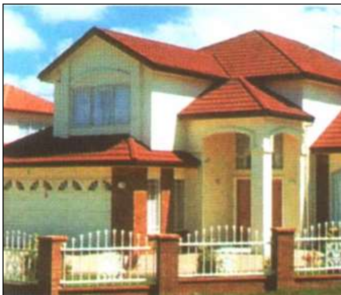
3.11-расм. Метробонд билан қопланган том
