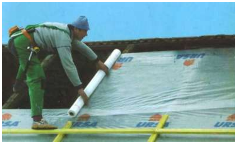
3.15-расм. "Урса-секо 500" асосидаги буғ-изоляцияси
