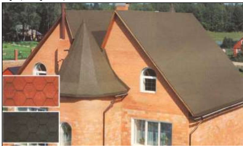
3.1-расм. «Катепал» плиткаларидан қурилган том
