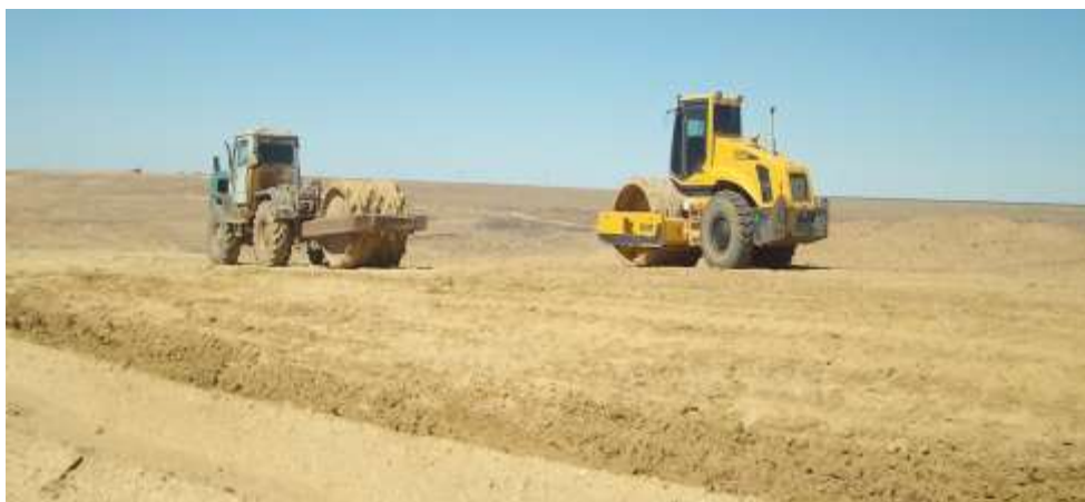
15- расм. Оптимал намликдаги грунтни катоклар ёрдамида зичлаш жараёни.
