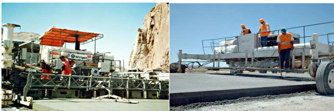
5-расм. А-380 автомобиль йўлида PAPINBURG фирмаси цементбетон қопламасини қуриш бўйича технологикжараёнлардан лавхалар
