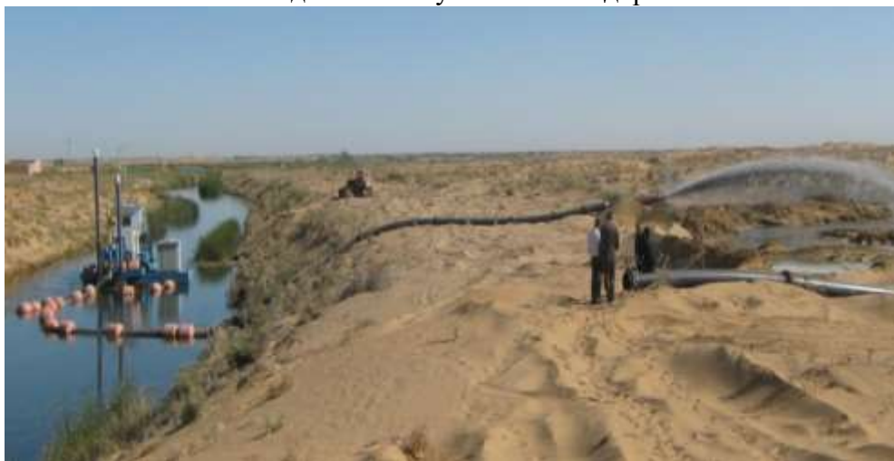
6-расм. №3 технологик схема бўйича коллектор ўзанини земснаряд билан чуқурлаштириш кўриниши.
