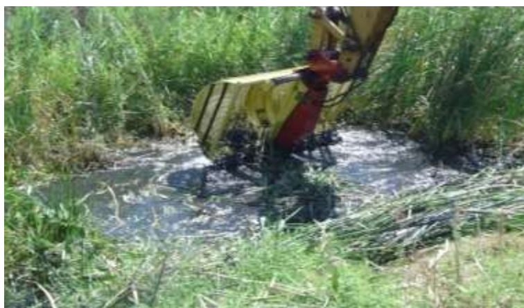
12-расм. Дағал пояли ўсимликларни бир чўмичли гидравлик экскаваторлар ва уларга илиниб ишлайдиган ковш ўргич билан сув остидан ўриб тозалаш.
