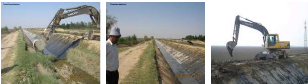
6- расм. Қопламали каналларни махсус чўмичли экскаватор билан тозалаш технологияси
