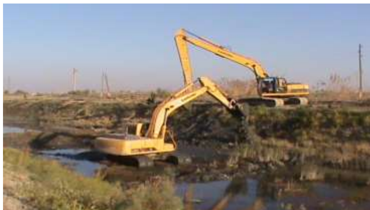
8-расм. №4 технологик схема бўйича коллектор ўзанини тозалаш кўриниши
