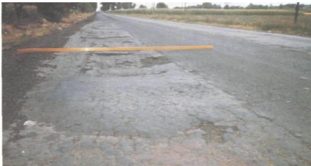
4.19-rasm. Kapital ta'mirlash talab etiladigan yo'l qoplamasi
