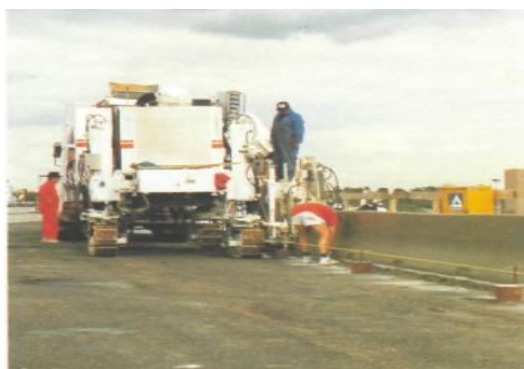
4.18-rasm. Sementbeton qoplamalarining choklarini to‘ldirish va ta‘mirlash
