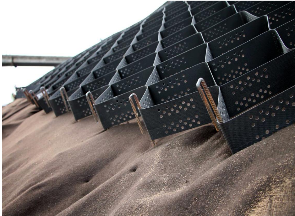
3.11-rasm. Gruntni mustahkamlash uchun, gruntlarni oqishi va surilishi, siljishini oldini olish uchun turli markadagi geosintetik materiallar
