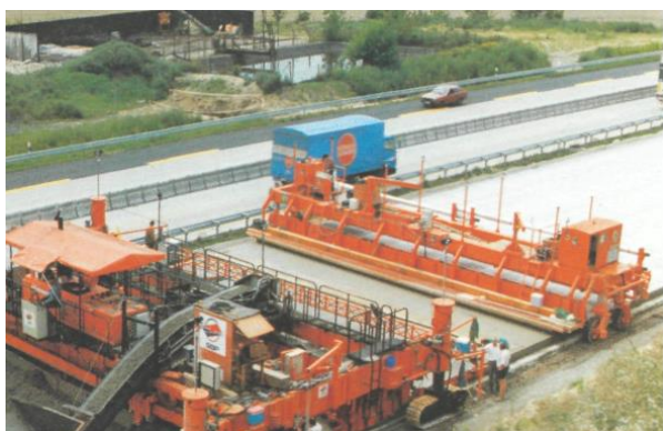
4.18-rasm. Sementbeton qoplamalarining choklarini to‘ldirish va ta‘mirlash
