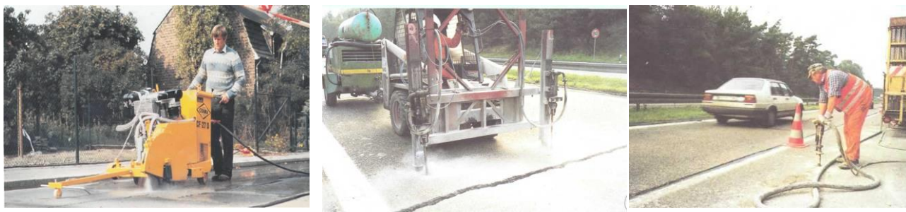
4.15-rasm. Sementbeton qoplamalari deformatsiya choklarini ta‘mirlash
