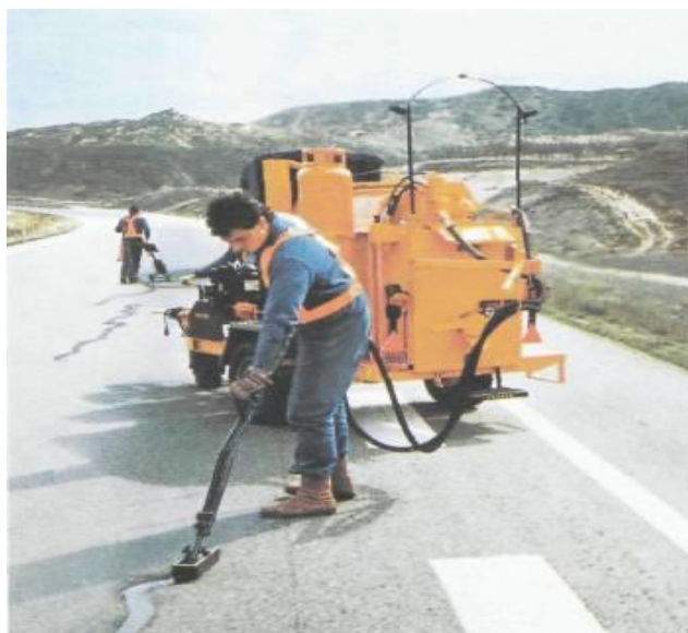
4.3-rasm. Qoplamadagi yoriqlarni berkitish
