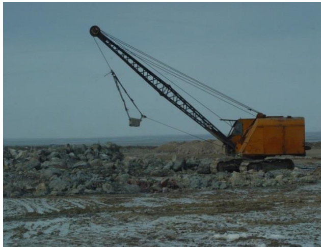
5.1 -rasm. Draglaynning umumiy ko'rinishi.
