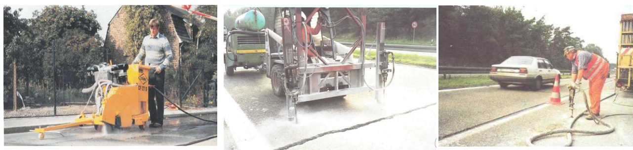
5.15-rasm. Sementbeton qoplamalari deformatsiya choklarini ta‘mirlash
