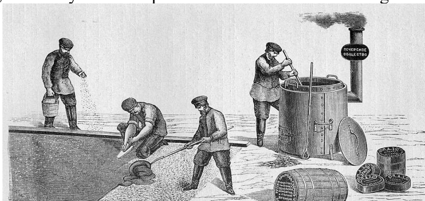
2.2-rasm. Dastlabki asfaltbeton qoplamalarni qurish jarayonlari
