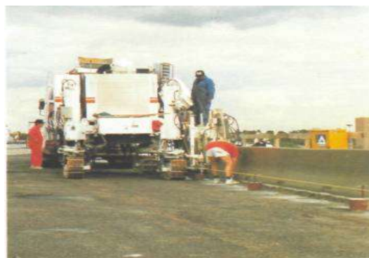
5.18-rasm. Sementbeton qoplamalarining choklarini to'ldirish va ta'mirlash
