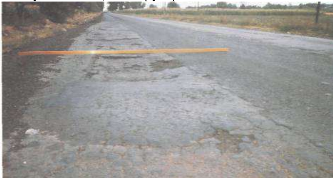
5.19-rasm. Kapital ta'mirlash talab etiladigan yo'l qoplamasi
