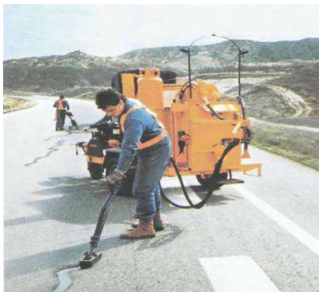
5.3-rasm. Qoplamadagi yoriqlarni berkitish
