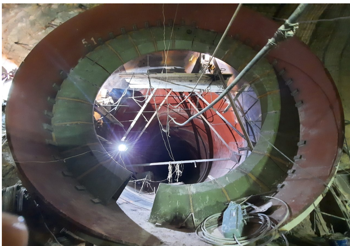
3.1-rasm. Pskom suv tashlash tunneliga o'rnatilgan diafragma.
