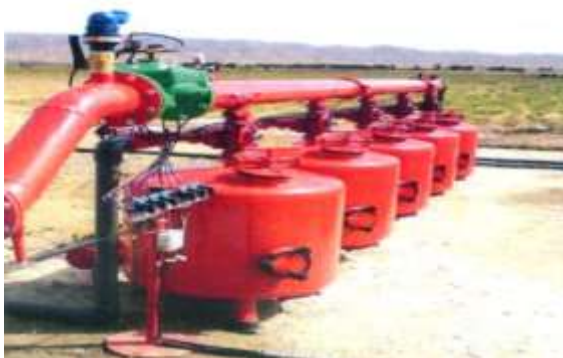
34- расм. Суғориш сувини тозаловчи қумли филтрлаш қурилмаси.
