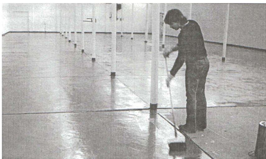
3.17-rasm. Espol epoksidli-slanesli quyma pollarni kartalar bo'yicha qurish
