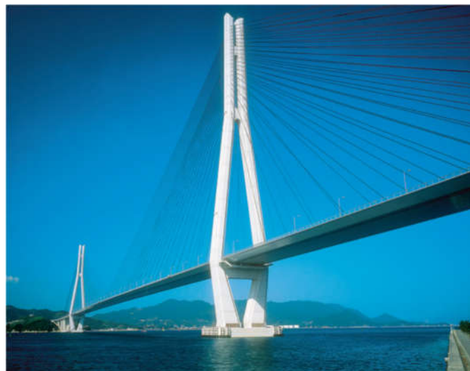
4.8-rasm. Modifikatsiyalangan betondan qurilgan Tokiodagi temirbeton ko‘prik
