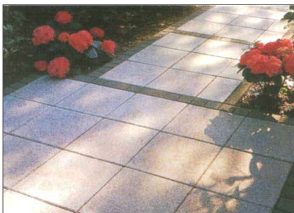
3.41-rasm. Mavze ichkarisidagi yo'llar qoplamalarini plitkalardan terish.
