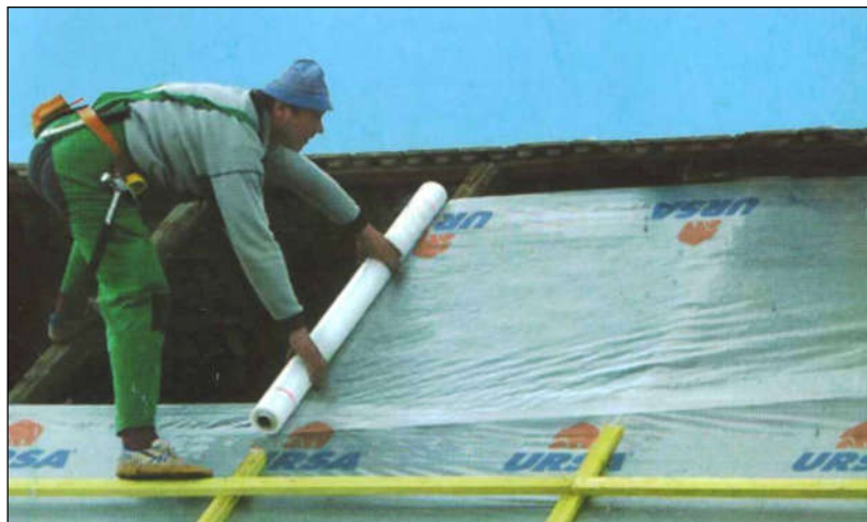
3.15-rasm. “Ursa-seko 500” asosidagi bug‘-izolyatsiyasi.
