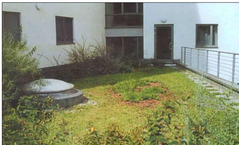
3.16-rasm. Ko‘kalamzorlashtirilgan tom qoplamasi.
