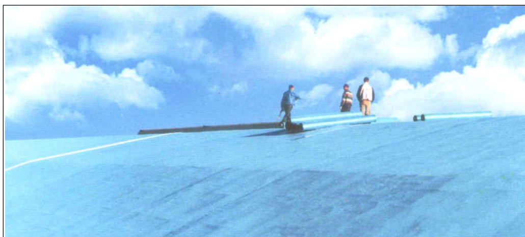
3.14-rasm.. Tez barpo qilinuvchi binoning Alkoplan membransidan qurilgan tom qoplamasi.
