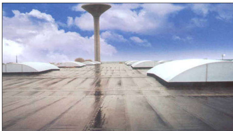
3.13-rasm. Sanoat binosining Rezitriks materialidan qurilgan tom qoplamasi.
