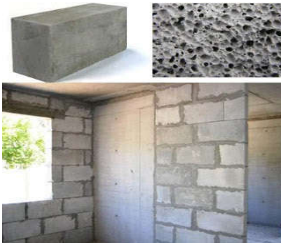
3-rasm. Ko‘pik beton tuzilmasi va undan turar-joy qurilishi.
