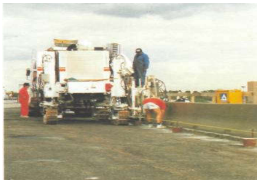
5.18-rasm. Sementbeton qoplamalarining choklarini to'ldirish va ta'mirlash
