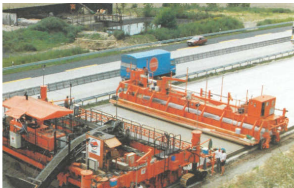
5.18-rasm. Sementbeton qoplamalarining choklarini to'ldirish va ta'mirlash
