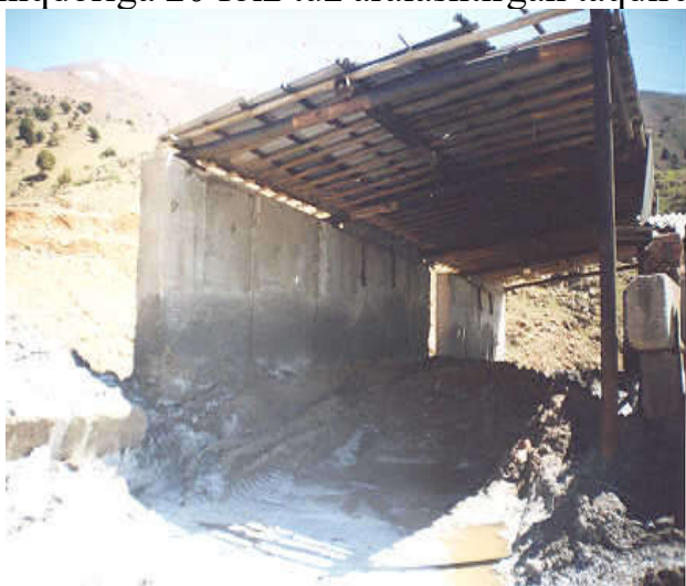
5.10-rasm. Sirpanchiqlikka qarshi ishlatiladigan materiallarni saqlash joyi (A-373 «Toshkent-O'sh» avtomobil yo'lining 165 km)
