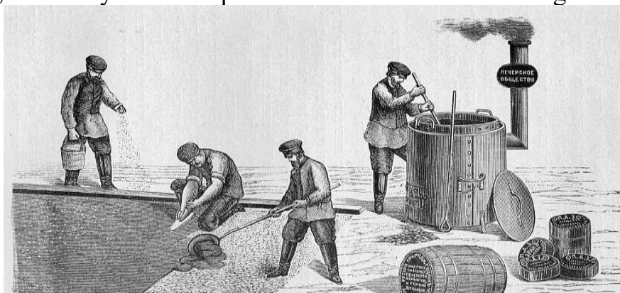
2.2-rasm. Dastlabki asfaltbeton qoplamalarni qurish jarayonlari
