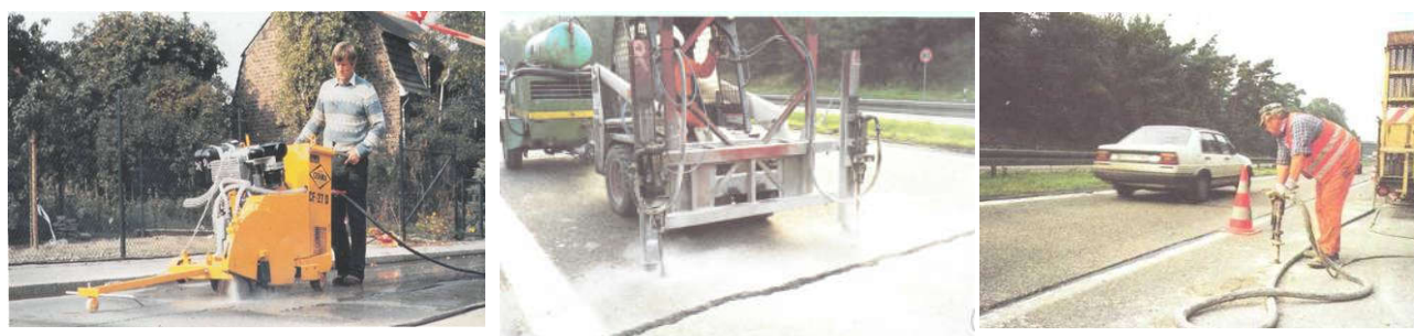
5.15-rasm. Sementbeton qoplamalari deformatsiya choklarini ta‘mirlash
