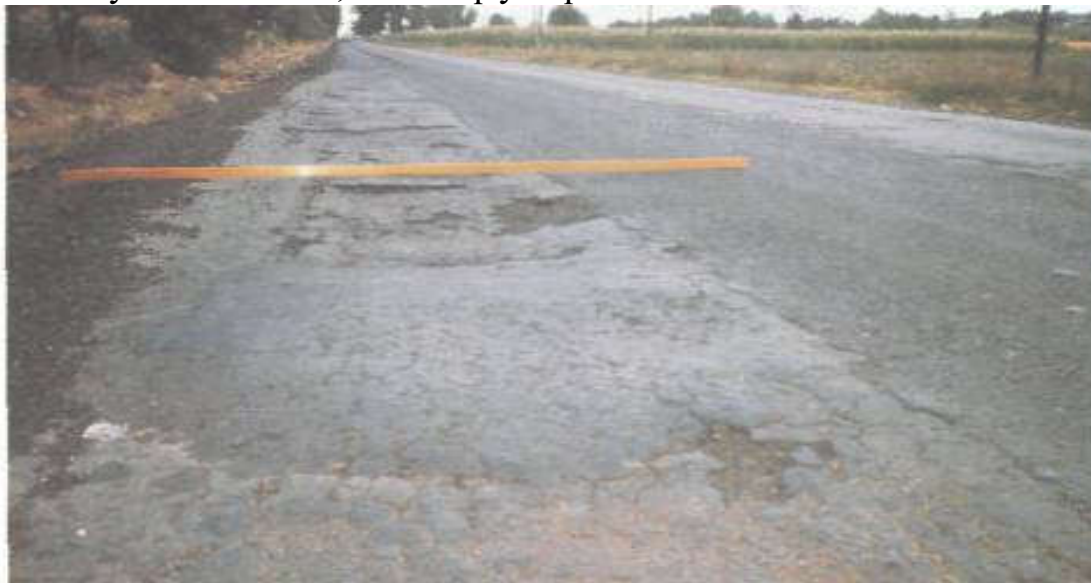
5.19-rasm. Kapital ta'mirlash talab etiladigan yo'l qoplamasi
