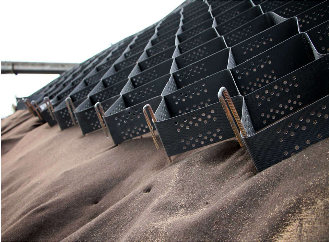
4.11-rasm. Gruntni mustahkamlash uchun, gruntlarni oqishi va surilishi, siljishini oldini olish uchun turli markadagi geosintetik materiallar
