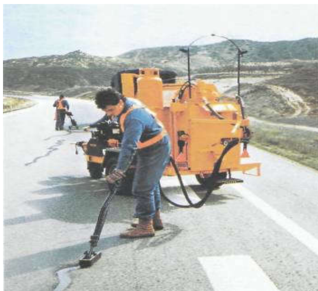
5.3-rasm. Qoplamadagi yoriqlarni berkitish
