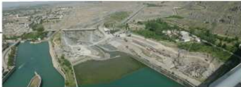
Фото 1. Строительство малой ГЭС, котлован под здание ГЭС, отводящий канал с выпуском в р. Карадарья, докер под р. Карадарья с подключением к каналу Шарикансай.
