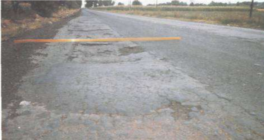
5.19-rasm. Kapital ta'mirlash talab etiladigan yo'l qoplamasi
