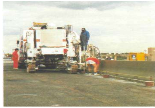
5.18-rasm. Sementbeton qoplamalarining choklarini to'ldirish va ta'mirlash
