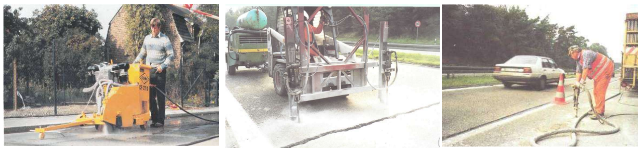
5.15-rasm. Sementbeton qoplamalari deformatsiya choklarini ta'mirlash
