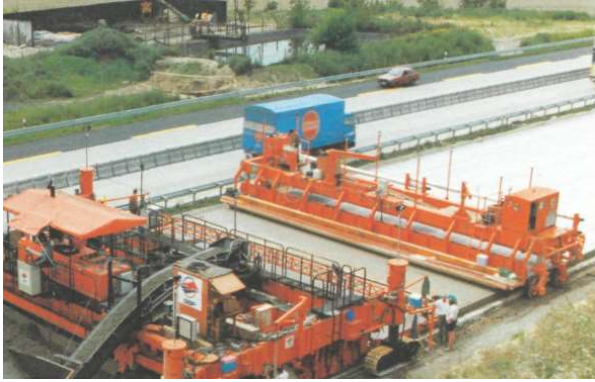
5.18-rasm. Sementbeton qoplamalarining choklarini to'ldirish va ta'mirlash
