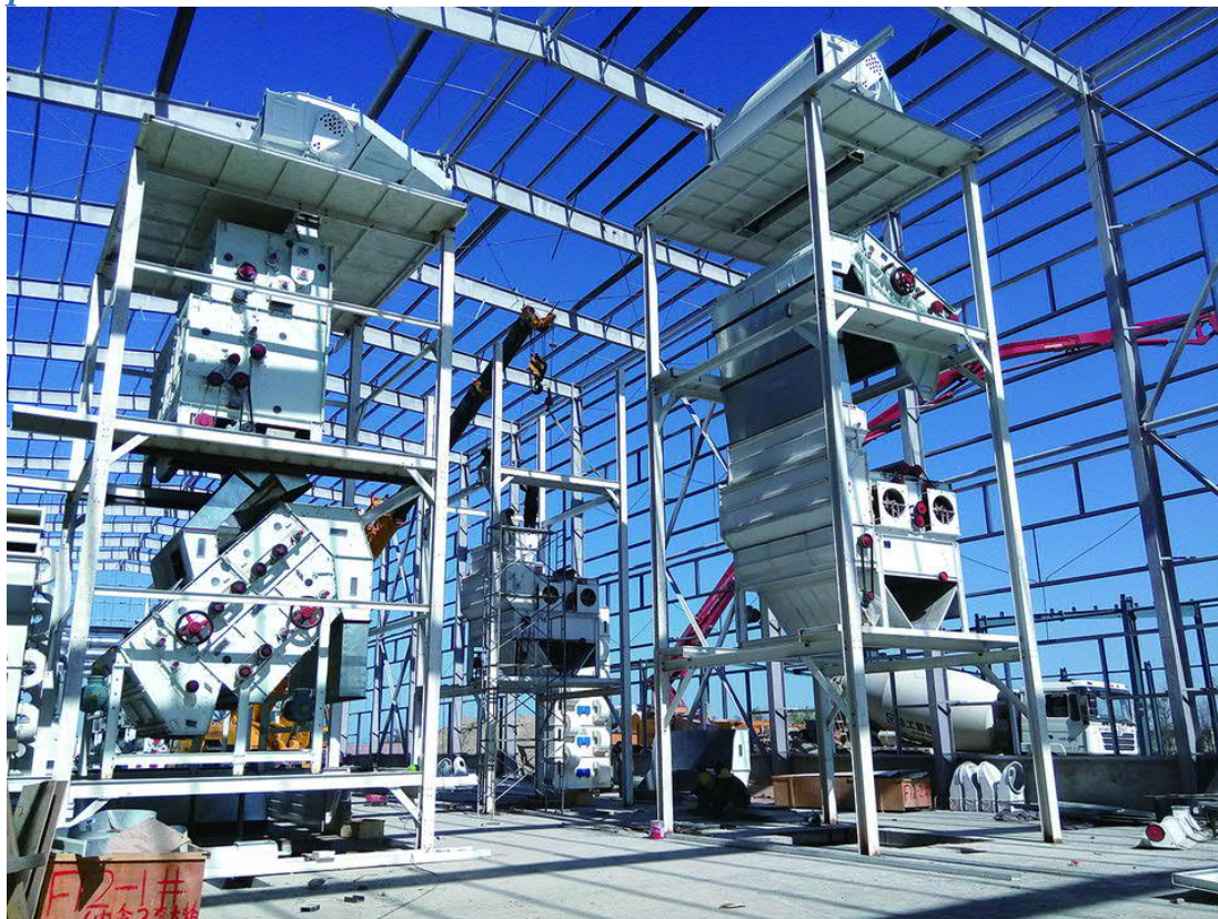
Texnologik uskunalarni montaj qilish jarayoni
