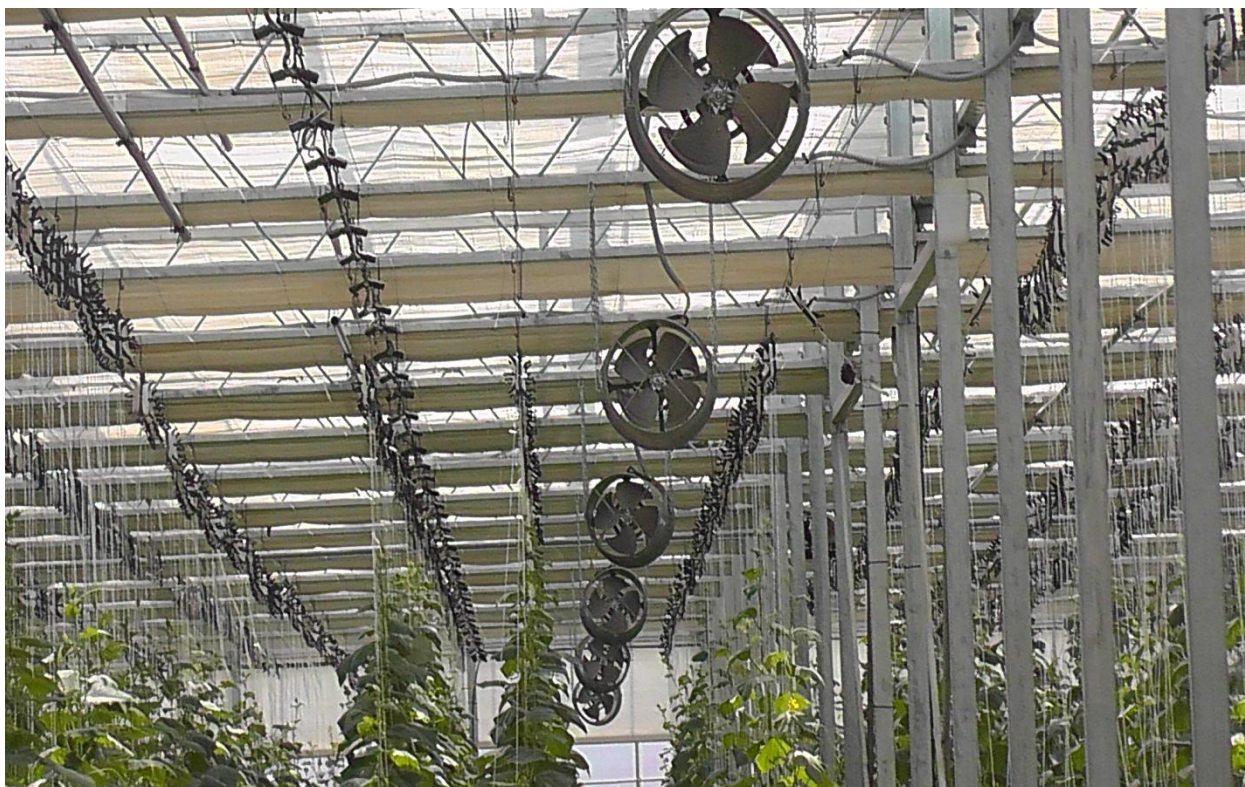
18-расм.Иссикхонада шамоллатиш тизимини автоматик бошқариш ТИЗИМИ
