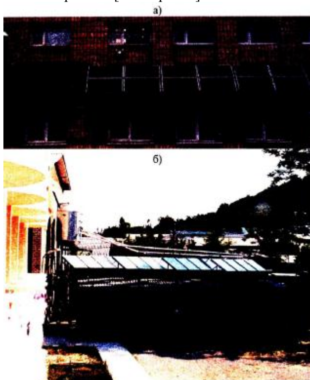
2.5-расм. Иссиқ сув билан таъминловчи гелиотизим: а - қуёш коллекторларининг умумий кўриниши; б – бинонинг томида коллекторларни жойлашиши.
