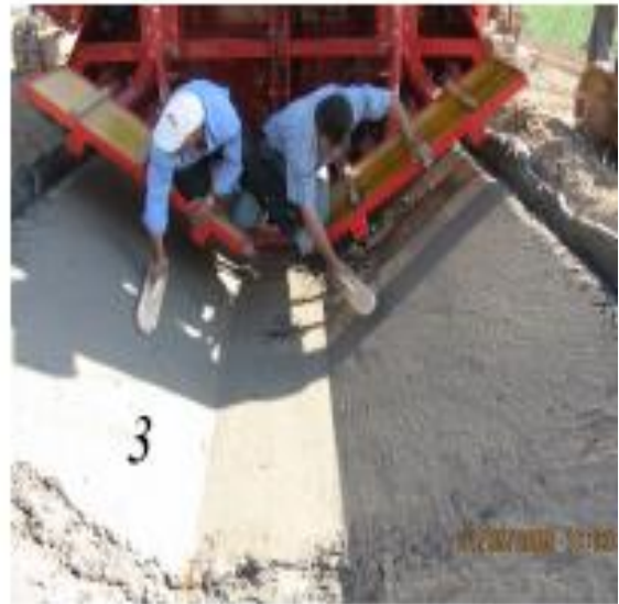
3.13- расм. Бетон қопламасига ишлов бериш:
