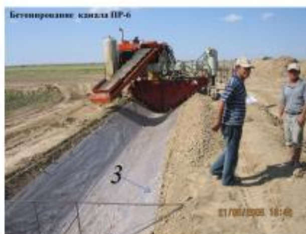
3.11 - расм. Канал ўзанини бетонлашга тайёрлаш:
