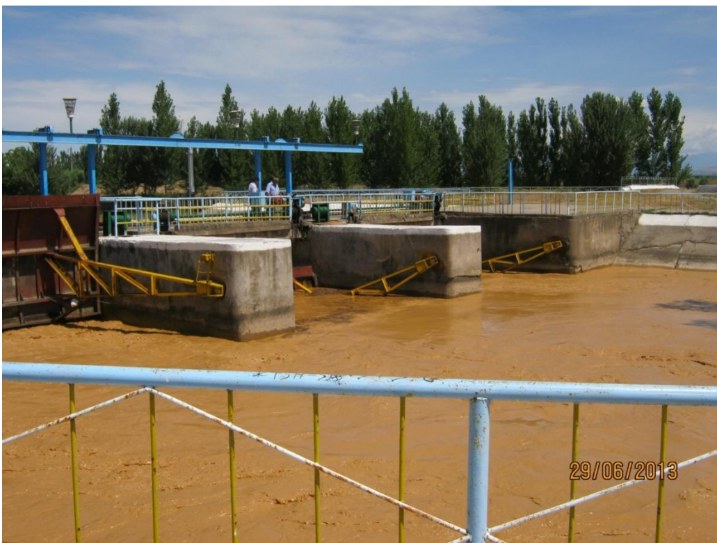
3.16 - расм Катта Фарғона каналига ўрнатилган сегментли затворларни пастки бўёфдан кўриниши.
