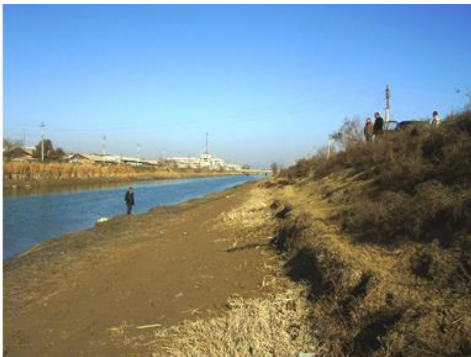
3.8. - расм. Дўстлик каналининг қабариқ қисмидаги лойқа чўкиш ҳолати
