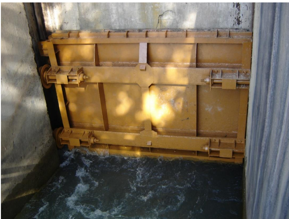
3.15 - расм Катта Фарғона каналнинг бош иншоотида ўрнатилган ясси затворларни пастки бўёфдан кўриниши.
