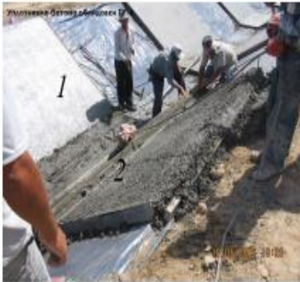
3.13- расм. Бетон қопламасига ишлов бериш:
