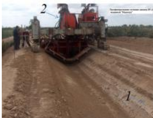
3.11 - расм. Канал ўзанини бетонлашга тайёрлаш:
