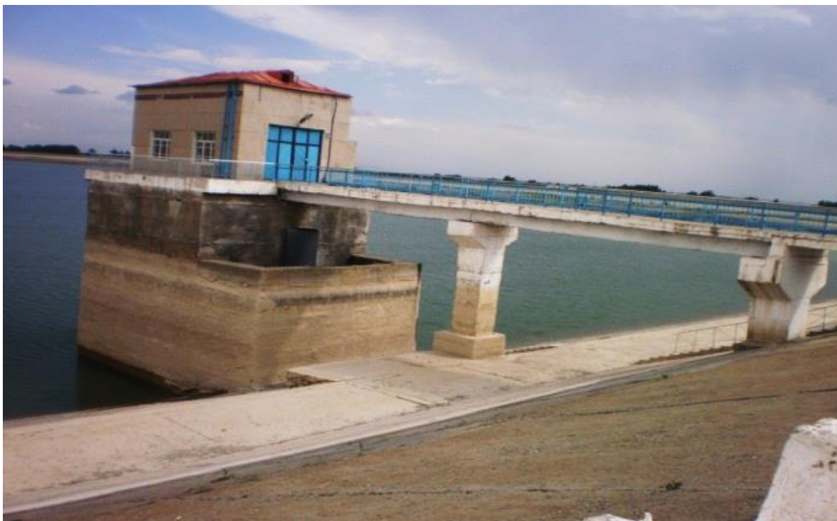
2.1 - расм. Оқ дарё сув омборидаги сув чиқаргич ва сув ташлагич иншооти.
