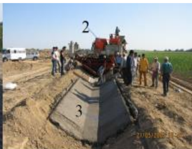
3.12 - расм. Канал ўзанини бетонлаш:
