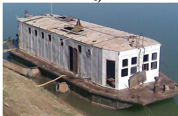
11-расм. Насос станциялари: а-доимий; б-сузиб турувчи.
