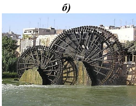
5-расм. Гидравлик энергия ёрдамида ҳаракатга келадиган чархпалаклар: а-Суриянинг Ҳамз шаҳридаги диаметри 22 м ва сув сарфи- Q = 4800 л /мин. нория-чархпалак; б-оддий чархпалак.
