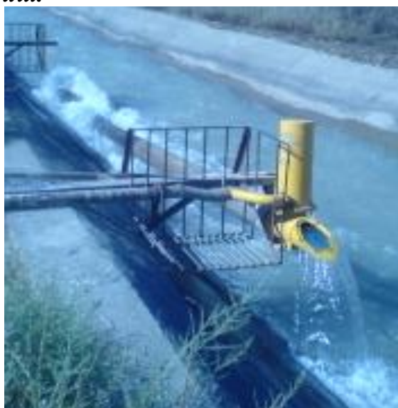
3.7-расм. Канал нишаблиги ҳисобига ўрнатилган гидротаран.
