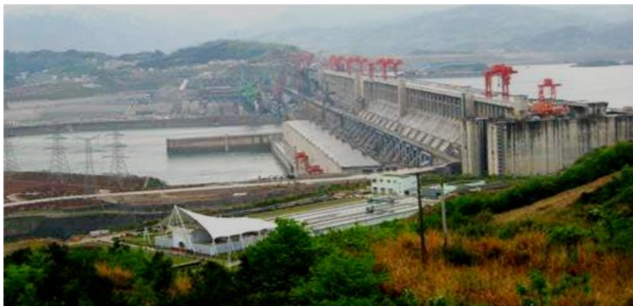
1.2-расм. Дунёдаги энг катта Уч дара гидроэлектростанцияси
