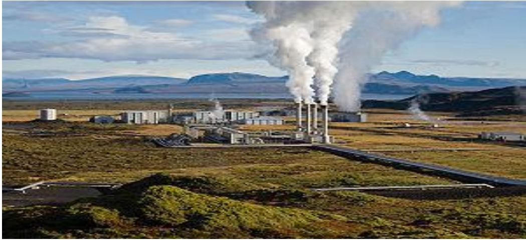
1.7-расм. Дунёдаги энг катта геотермал электростанцияси.
