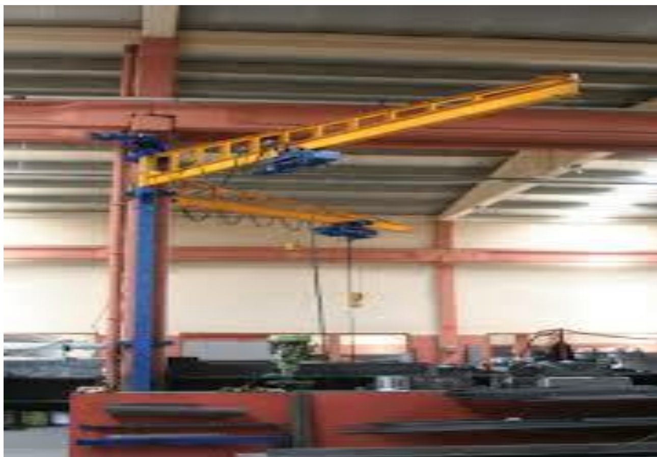
1.11 Rasm. Po‘lat ustunlarga maxkamlangan sanoat binosining ko‘tarma kranlari.
