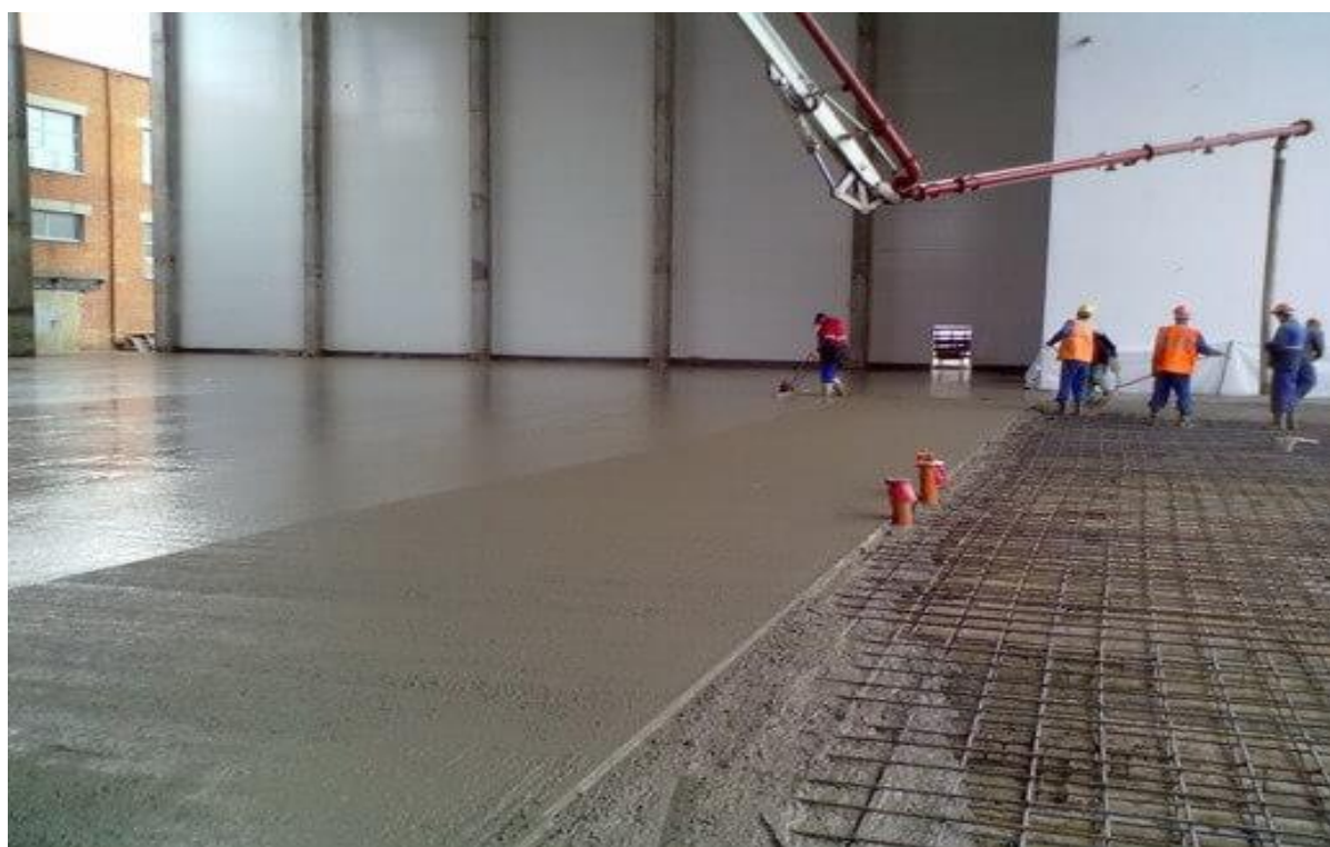
2.61-rasm. Sanoat binolarining temirbeton pollarini tayyorlash jarayonlari
