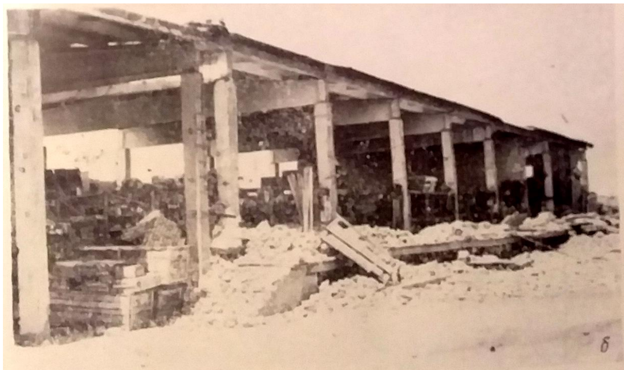
1.19-rasm Gazli shahrida joylashgan sanoat binosi omborining zilziladan keyingi ko'rinishi:
