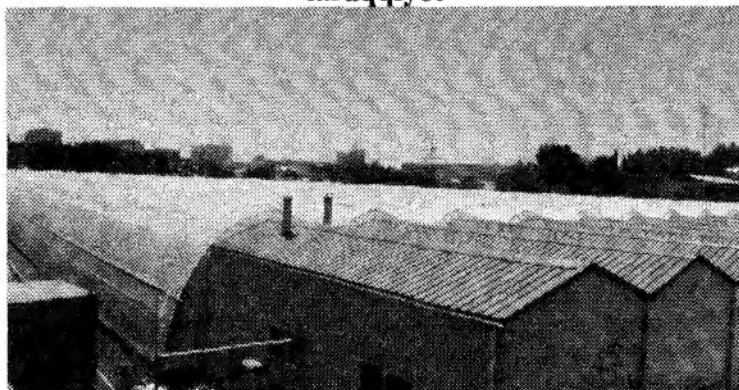
12.1-rasm. ToshDAU dagi elektrlashtirilgan va COICA issiqxona xo'jaligini umumiy ko'rinishi
