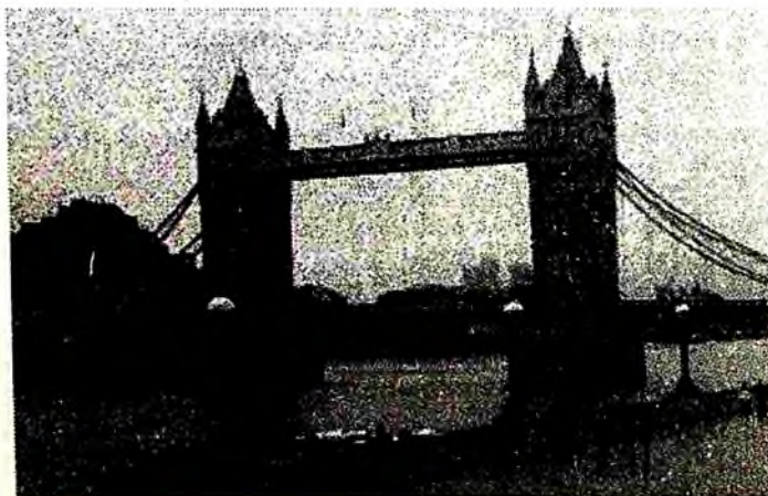
3-rasm. 1886- va 1894- yillarda qurib tugatilgan osma ko'prik. Ko'prikni bog'lovchi vosita beton va po'lat qotishmalli tross. Ko'prikning uzunligi 244m. Qo'yilgan moslamalar qum, tuproq va tog' jinslarini oqimi hamda tabiiy ofatlarni oldini olishda asosiy rol o'ynaydi.
