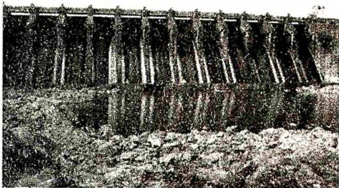
4-rasm. Miathon platinasi ko'rsatilgan. Platinaning uzunligi 4789m, balandligi 50m. Bu platina maxsus sel va boshqa kuchli yog'ingarchiliklarni oldini olish, Shuning bilan birga 60 000 kVt energiya beradigan stansiyaning yuritish uchun qurilgan.
