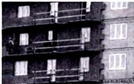
14.2-rasm. Binoni tashqaridan issiqlik izolyatsiyasi materiallari bilan qoplash.
