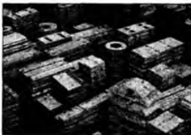
7.6-rasm. Yig'ma temirbeton konstruksiyalarni omborlarga joylashtirish.
