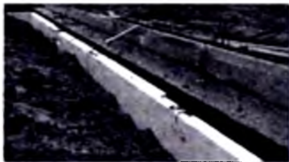
14.4-rasm. Poydevorni issiqlik izolyatsiyalash.
