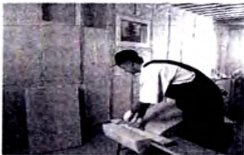
14.1-rasm. Binoni ichkaridan issiqlik izolyatsiyasi materiallari bilan qoplash.
